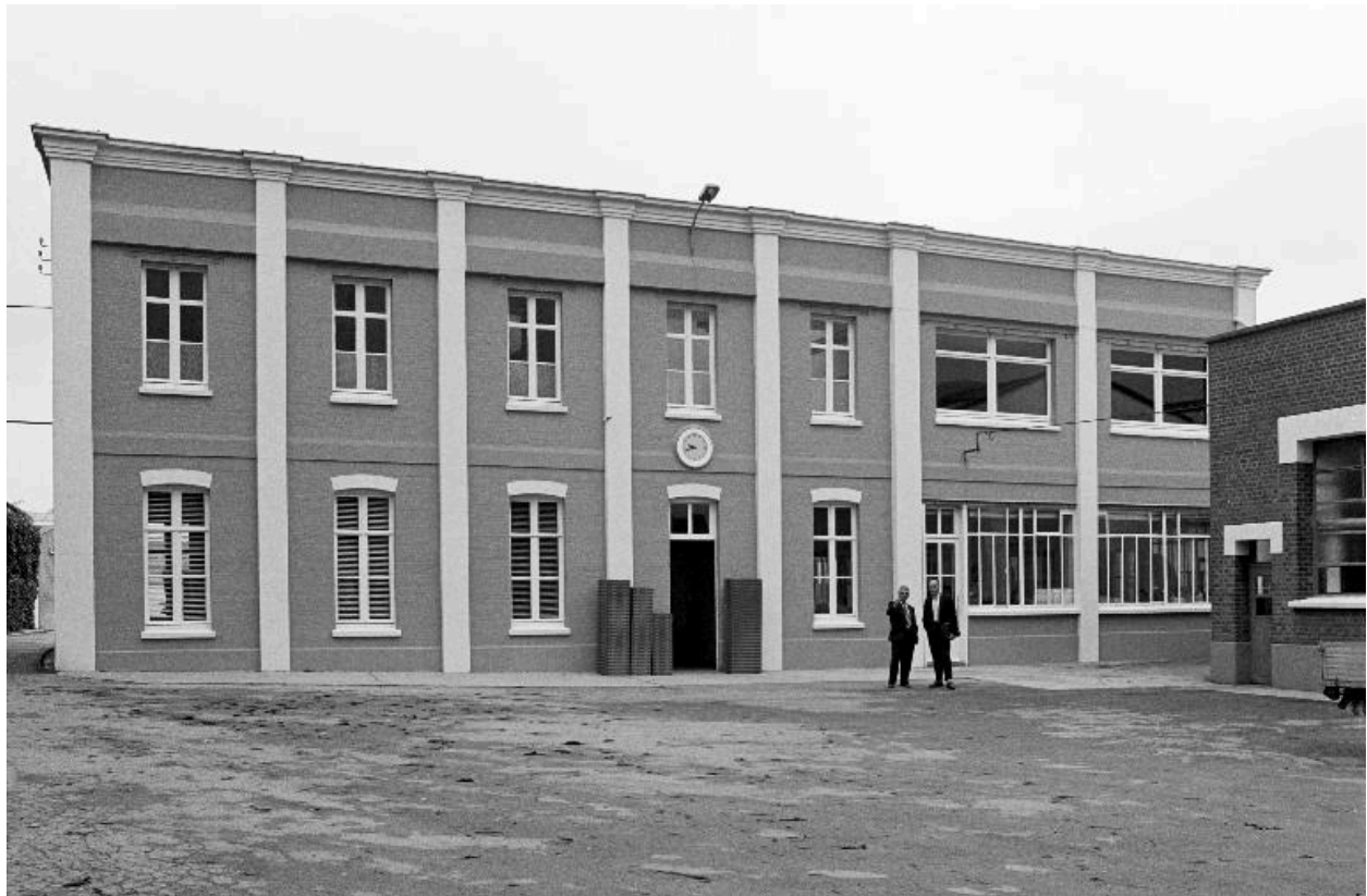
Bureau, flanc sud, en 1990.
