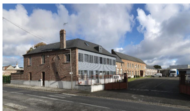
Vue de trois-quarts des bureaux.
