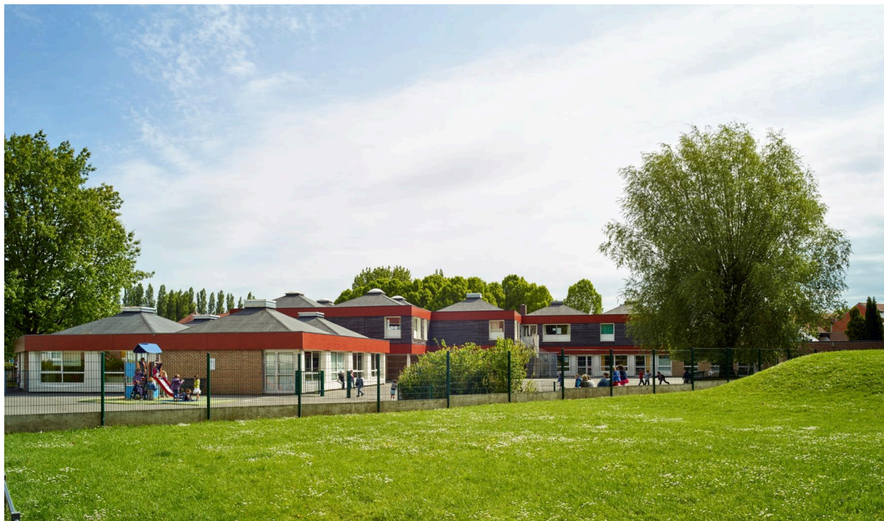
Vue du groupe scolaire depuis le nord.
