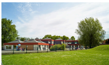
Vue du groupe scolaire depuis le nord. Phot. Pierre Thibaut IVR32_20185900198NUCA
