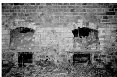
Intérieur du four avant son démontage : détail des cavités d'enfournement (AP). Phot. Thierry Lefébure IVR22_20006000210XB
