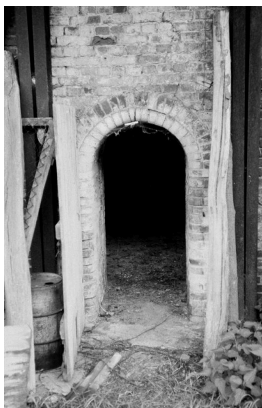
Entrée du four, aujourd'hui démonté (AP). Phot. Thierry Lefébure IVR22_20006000214XB
