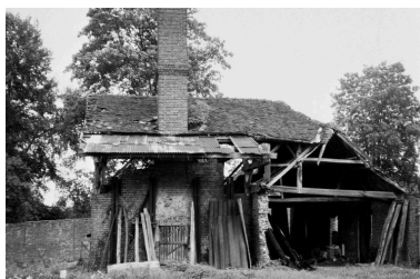
Le four de cuisson et sa cheminée carrée avant sa destruction (AP). Phot. Thierry Lefébure IVR22_20006000215XB
