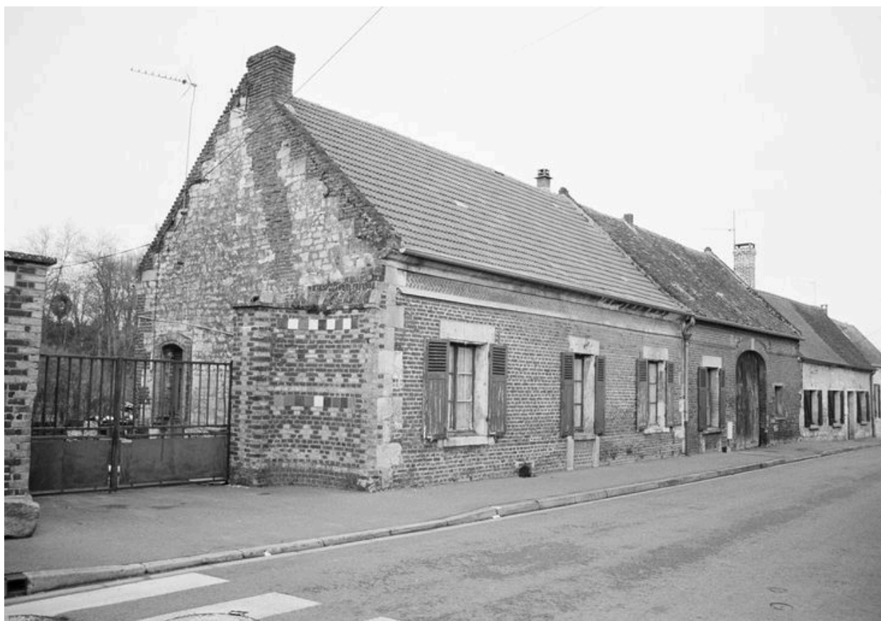
Maison de briquetier : façade sur rue.
