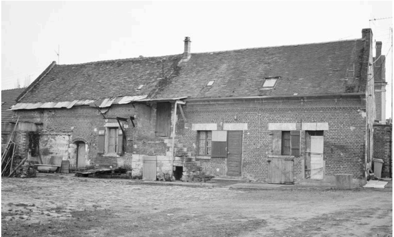
Maison de briquetier : façade sur cour.
