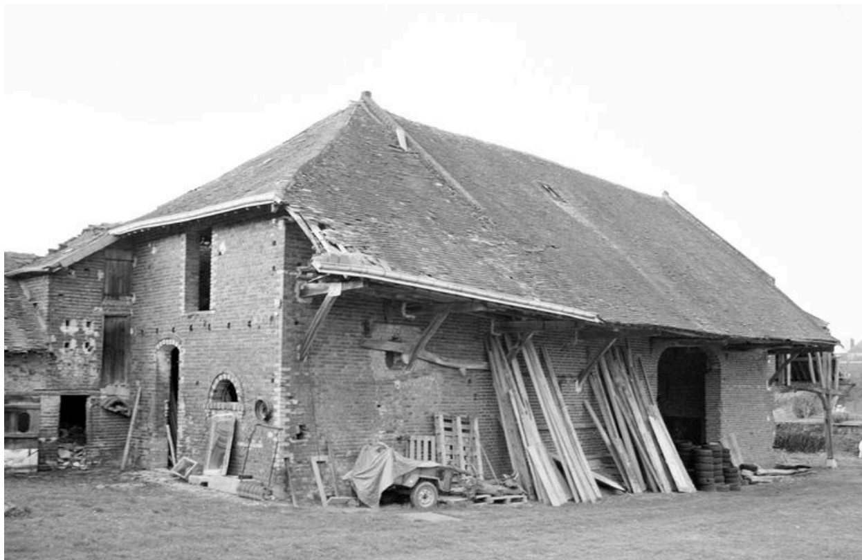
Grange : façade sur cour.
