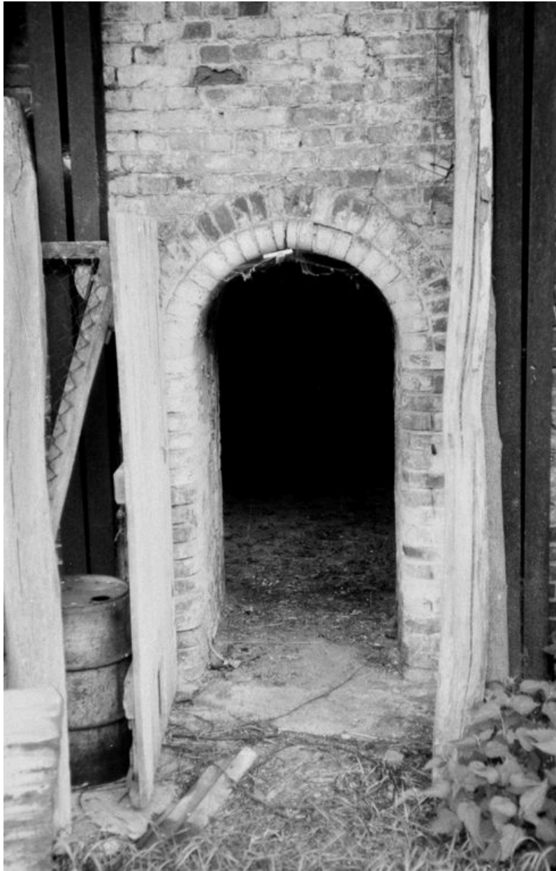
Entrée du four, aujourd'hui démonté (AP).
