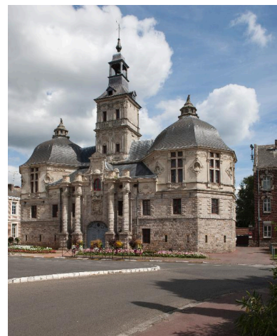
Vue générale de l'échevinage. Phot. Pierre Thibaut IVR31_20125902061NUCA
