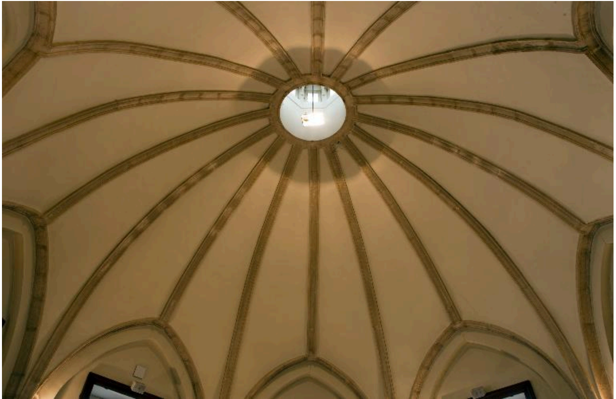
Vue générale de la voûte de la salle du pavillon de gauche.
