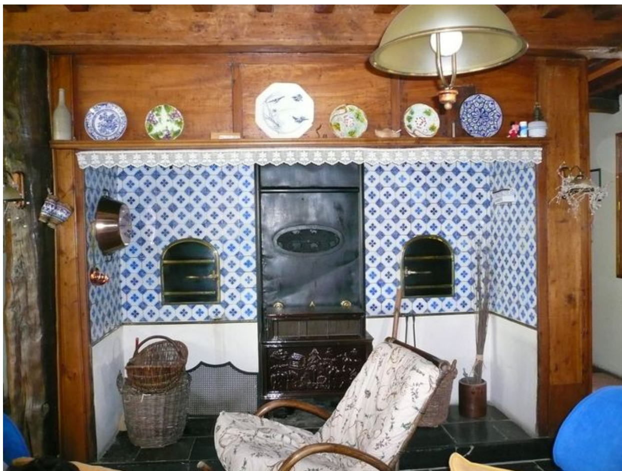
Exemple de cheminée entièrement en bois, recouverte de carreaux de Vron, avec deux niches munies de portes en fonte et système de foyer à la prussienne.
