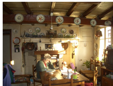
Intérieur d'une salle commune avec disposition des éléments traditionnels : cheminée avec entablement mouluré, portes, placards intégrés, solives apparentes.
