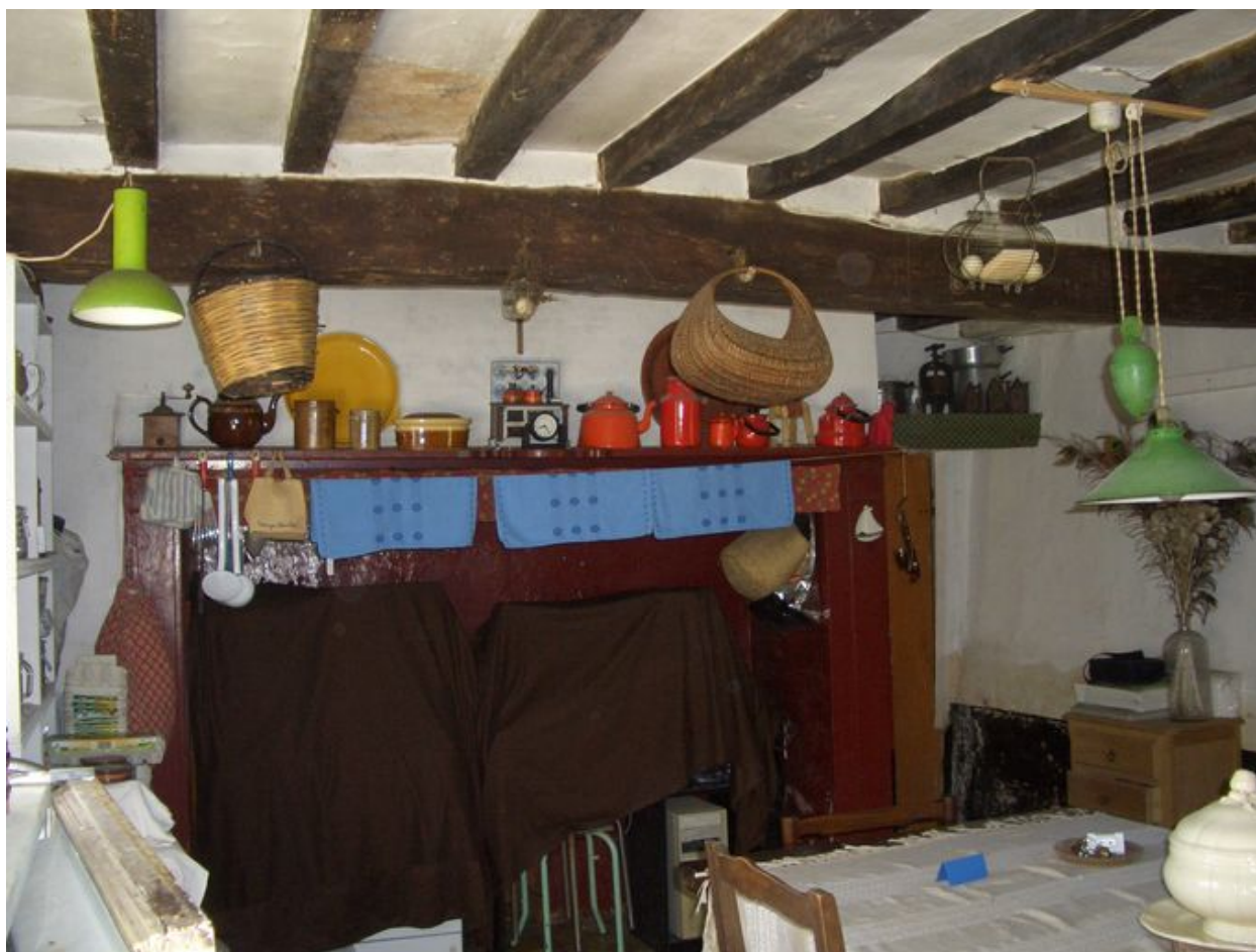
Vue intérieure d'une salle commune avec plafond à solives et cheminée munie d'une tablette moulurée.
