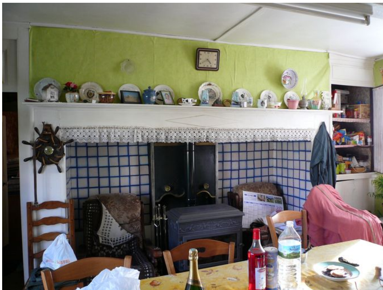
Exemple d'une cheminée ayant conservé ses carreaux dits de Vron et son entablement mouluré, avec décor géométrique.
