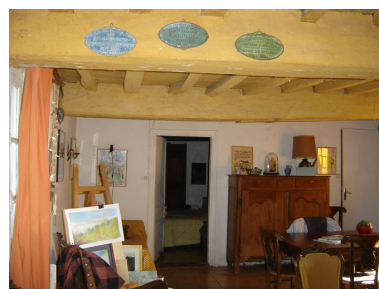
Vue intérieure d'une salle présentant un plafond composé de solives sur poutres maîtresses, le tout peint en jaune, couleur d'origine.
