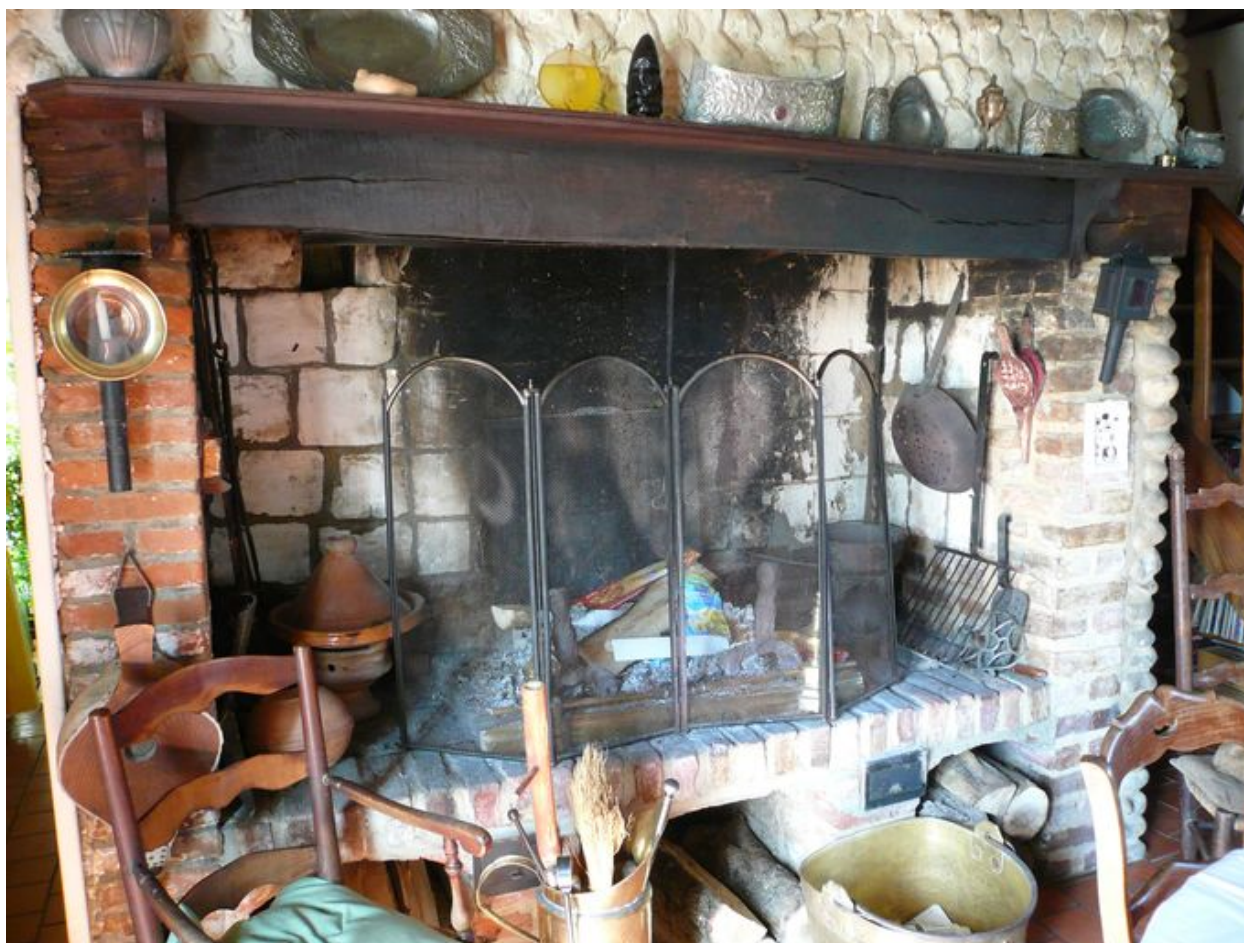
Exemple d'une cheminée de construction soignée, en moellons de pierre calcaire et jambes en brique ; le foyer a été surhaussé.
