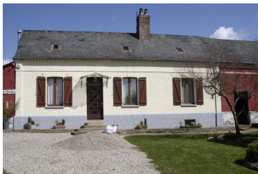
Vue du logis. Phot. Inès Guérin IVR22_20058005564NUCA
