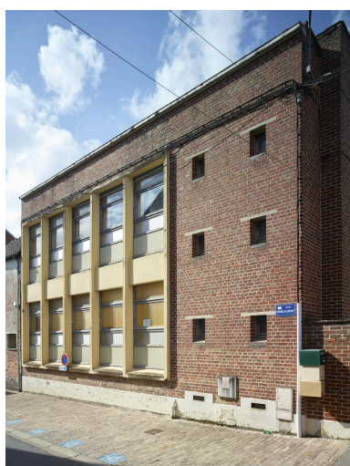
Ancienne école de filles - 24, rue Baillon : vue de la façade
