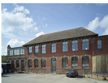
Ancienne école de filles - 24, rue Baillon : vue de la façade principale du bâtiment sur cour construit au début du XXe siècle. Les 3 travées de gauche datent de l'extension des années 1930.
