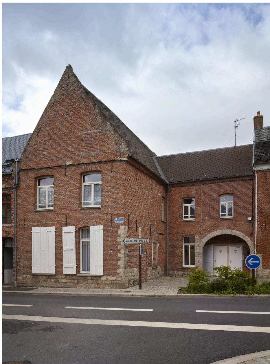
Maison - 15-17, rue de la Nouvelle-Zélande. Acquisée par la ville en 1937 pour servir de logement à la directrice de l'école de filles.
