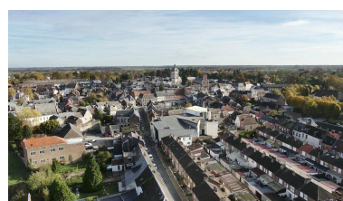
Façade latérale du bâtiment de 1930 de l'école de fille (premier plan à gauche).
