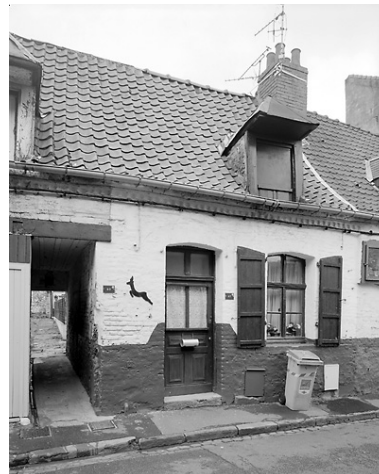
Vue générale du n° 65 de la rue Neuve (état en 2000).
