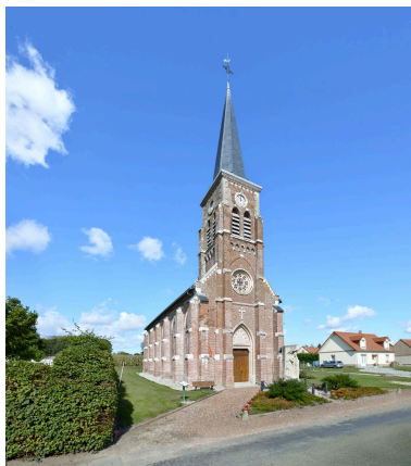
Vue d'ensemble de l'église depuis l'est. Phot. Thierry Lefébure IVR32_20258002077NUCA
