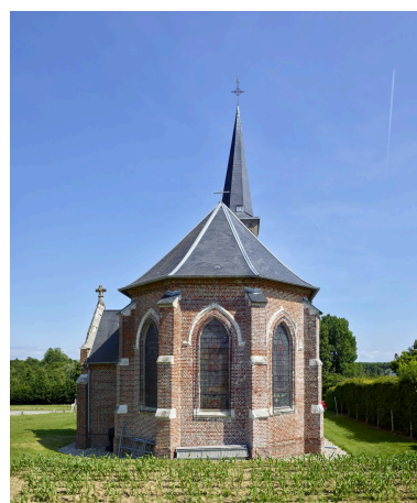
Vue du chevet de l'église, orientée à l'ouest. Phot. Thierry Lefébure IVR32_20258001215NUCA
