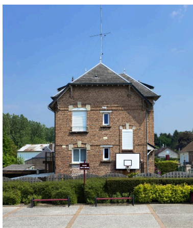
Façade latérale d'une des deux maisons d'ingénieur. Phot. Thierry Lefébure IVR32_20160200038NUC2A
