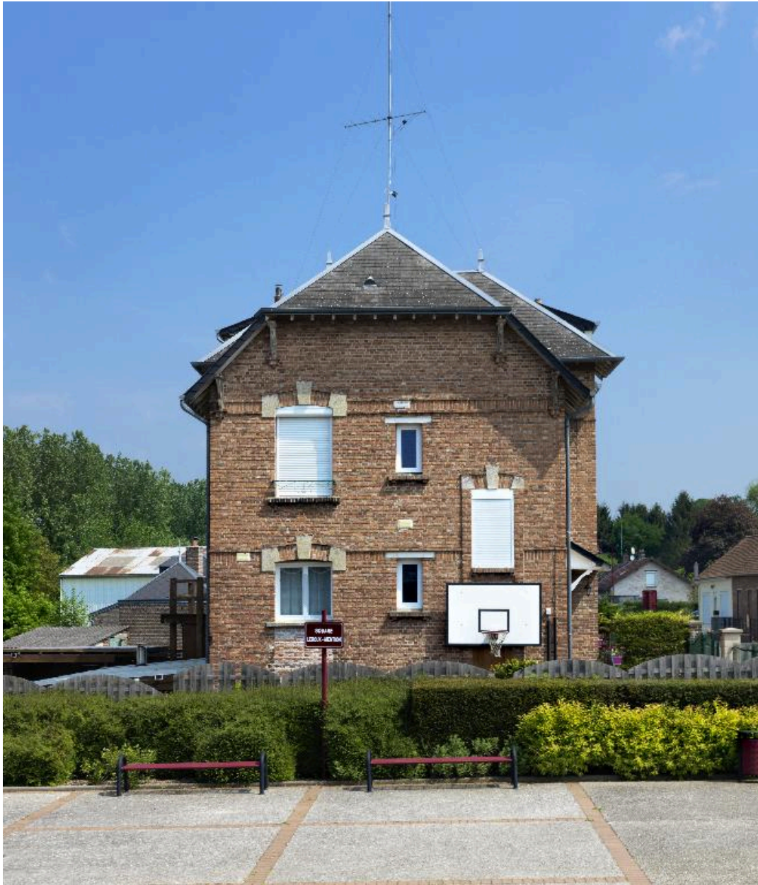
Façade latérale d'une des deux maisons d'ingénieur.
