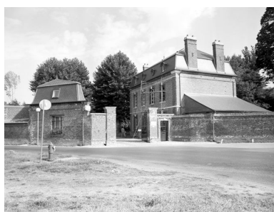
Le logement patronal et la conciergerie situés à l'entrée de l'usine, en 1999. Phot. Laurent Jumel IVR22_19966002499X
