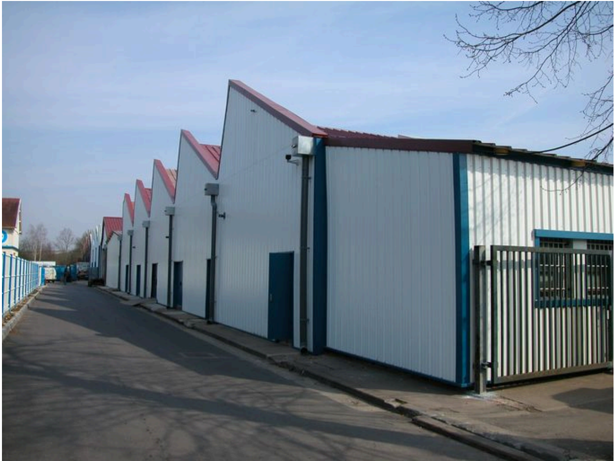
Façade ouest de l'atelier de fabrication.
