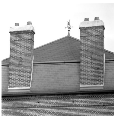
Détails des tirants en fer forgé situés sur les cheminées du logement patronal et figurant les initiales BL, Bollé Letellier. Phot. Laurent Jumel IVR22_19966002501X
