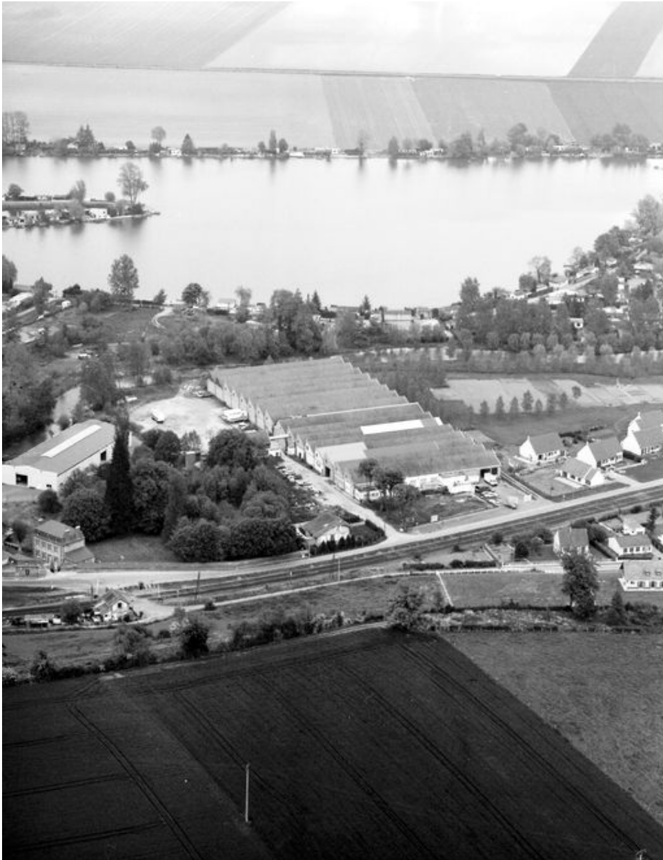
Vue aérienne de l'usine en 1994.
