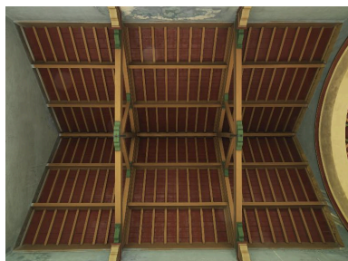
Vue de la charpente de l'une des nefs des malades. Phot. Thierry Lefébure IVR22_20128000048NUC4A
