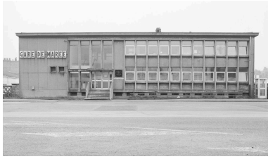
Façade sur voie. Phot. Philippe Dapvril IVR31_19946200569X
