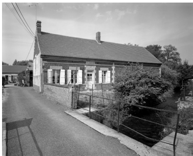
Logis. Elévation antérieure. Phot. Jean-Michel Perrin IVR22_19866000134V
