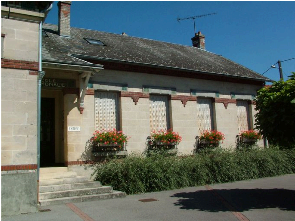
Vue des bâtiments scolaires.
