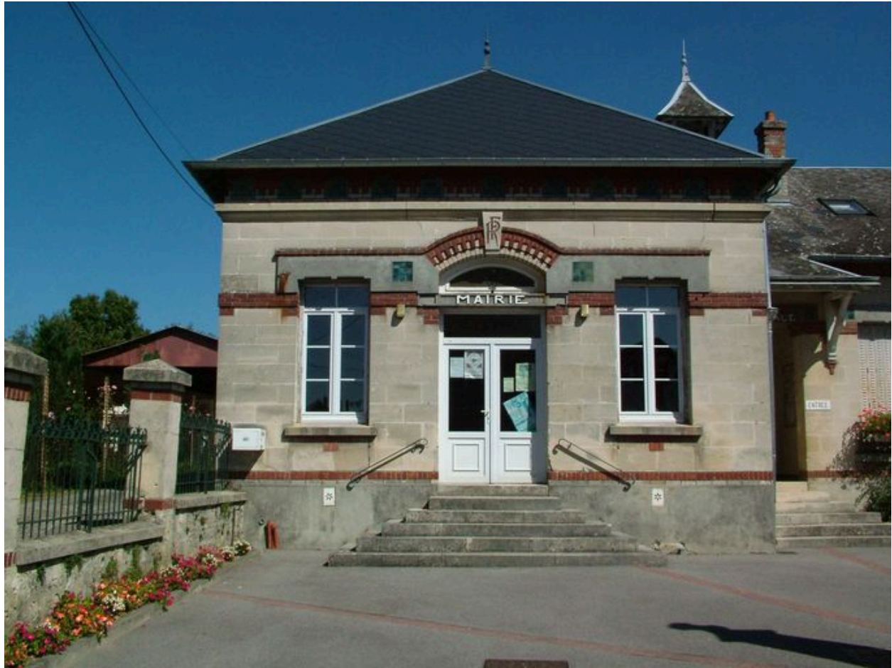
Vue détaillée du bâtiment de la mairie.
