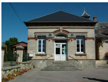
Vue détaillée du bâtiment de la mairie. Phot. Inès Guérin IVR22_20030202473NUCA
