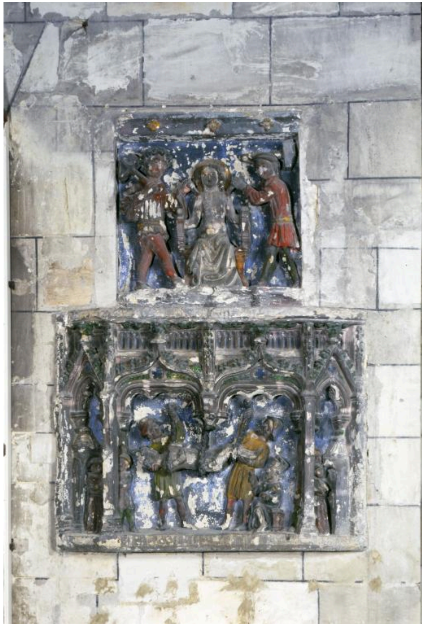
Vue des 2 bas-reliefs superposés, état avant restauration en 1998.
