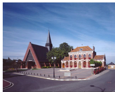
Vue générale. Phot. Thierry Lefébure IVR22_20068000439VA
