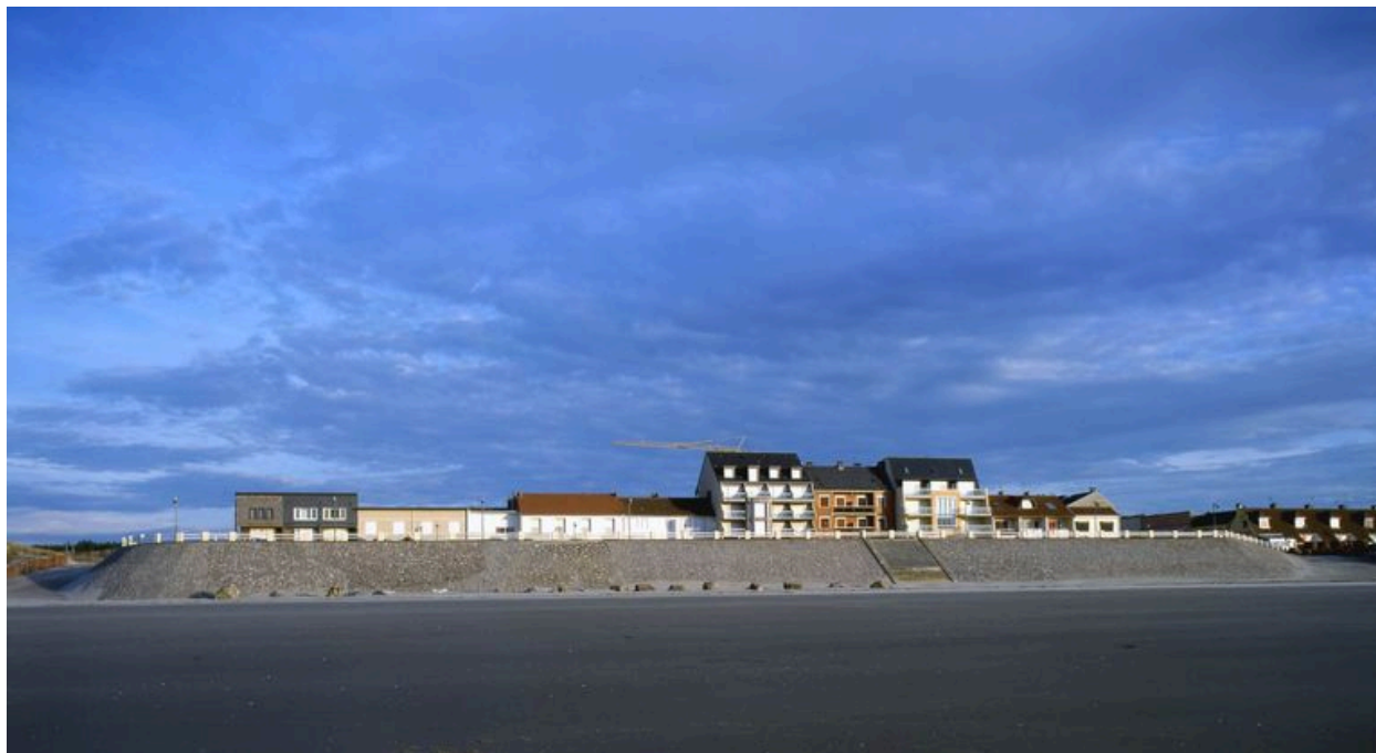
La digue nord, vue d'ensemble depuis la plage.
