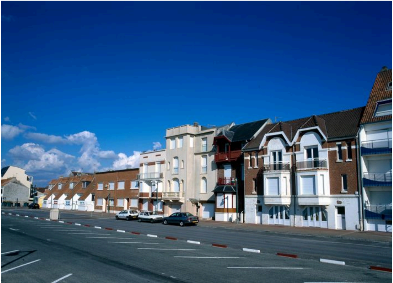
Les constructions de la digue sud.
