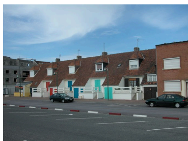
Ensemble de maisons, terrasse Marcel-Vasseur (1991 XA 65 à 69). Phot. Elisabeth Justome IVR22_20058003974NUCA
