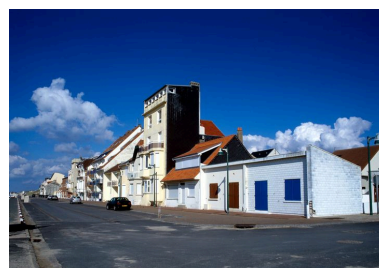
Les constructions du front de mer, vue depuis le sud. Phot. Marie-Laure Monnehay-Vulliet IVR22_20038001056XA
