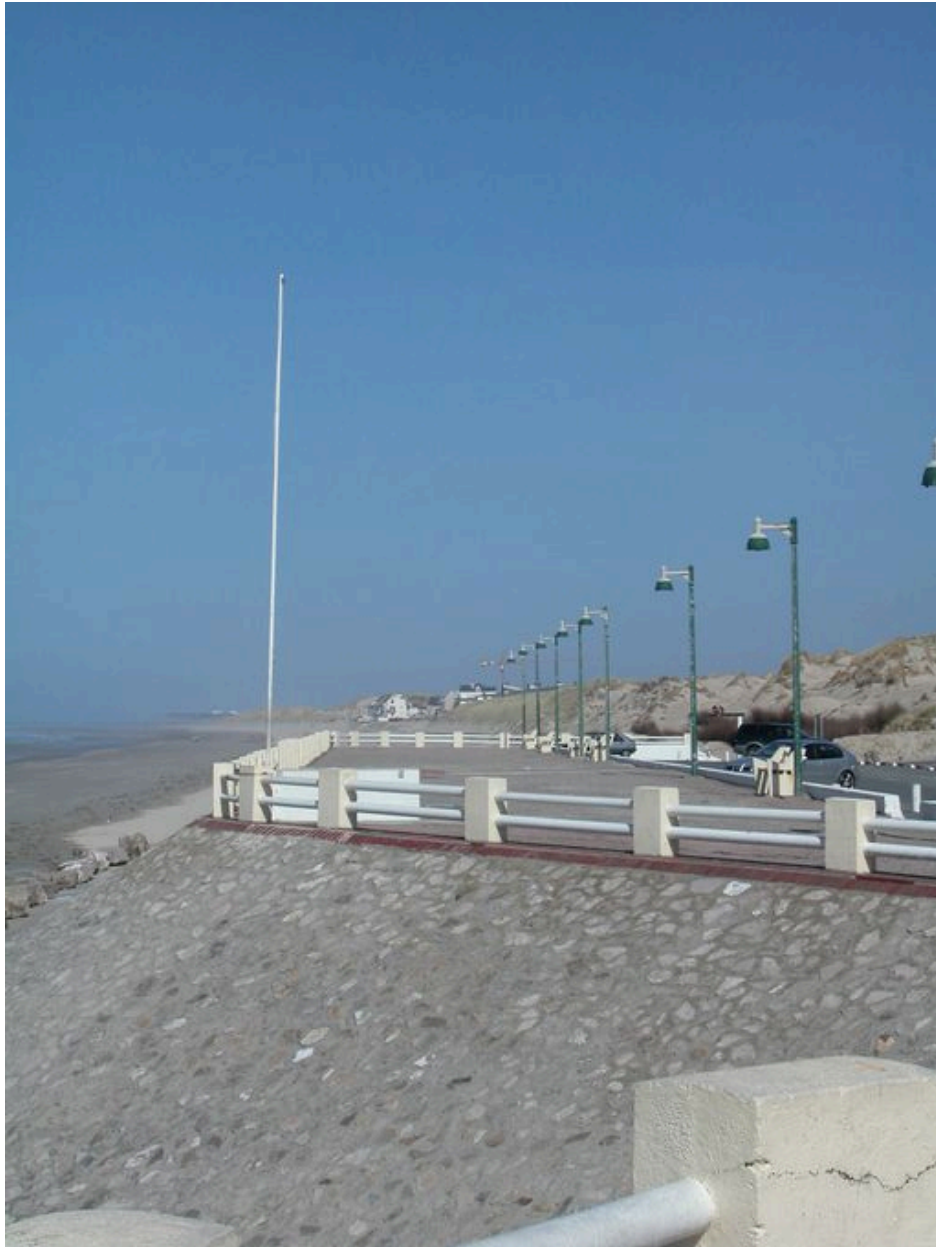
La digue nord, vue depuis le sud.
