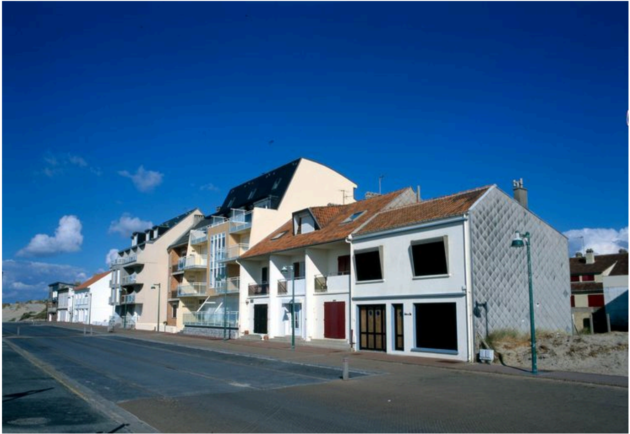
Les constructions de la digue nord.
