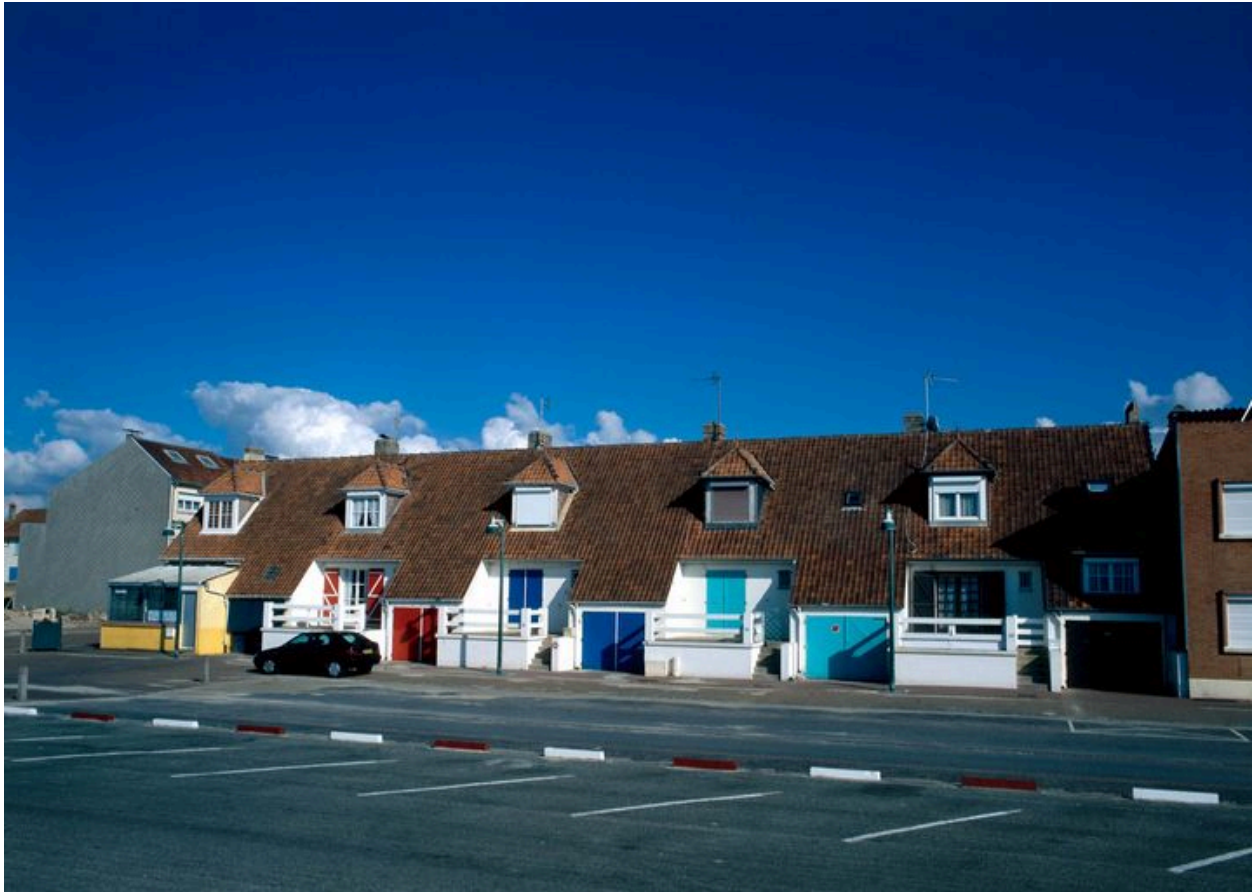
Ensemble de cinq maisons accolées, digue sud.
