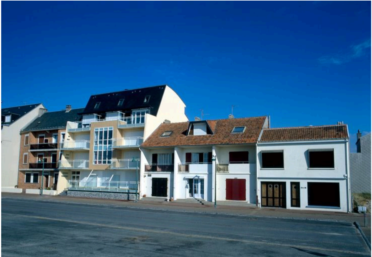
Les constructions de la digue nord.
