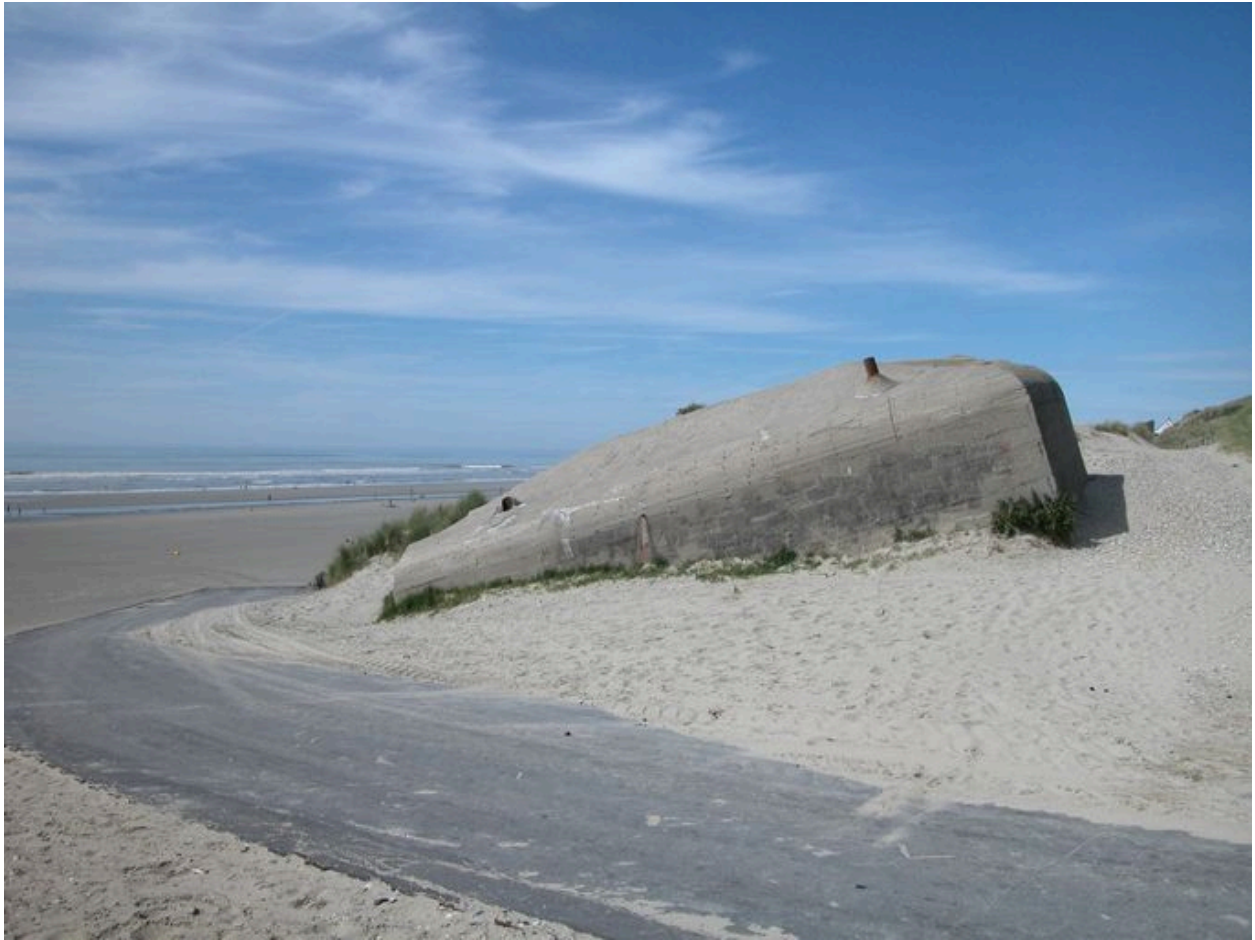
Un blockhaus au sud de la digue.
