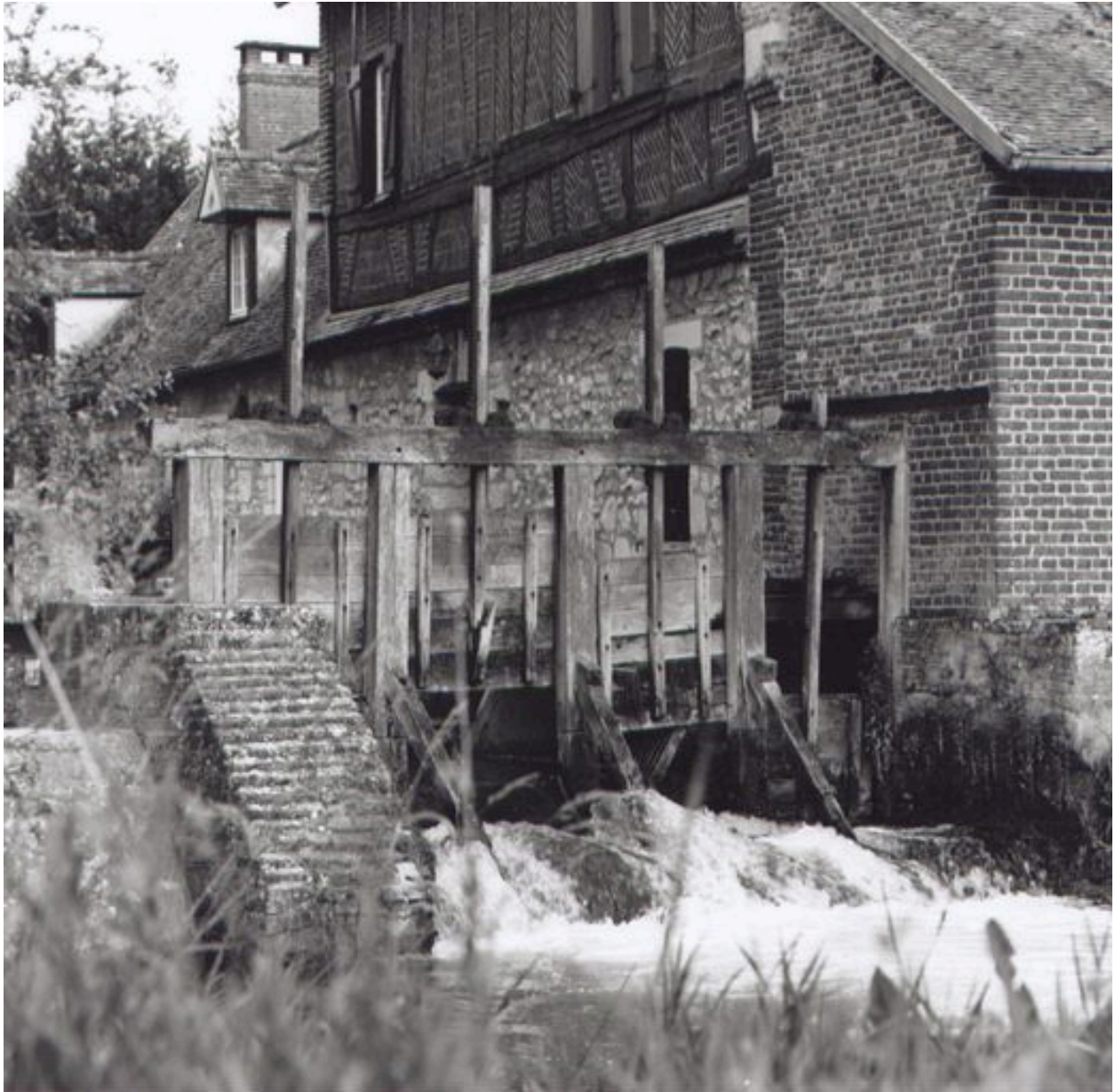
Les vannes de décharge.
