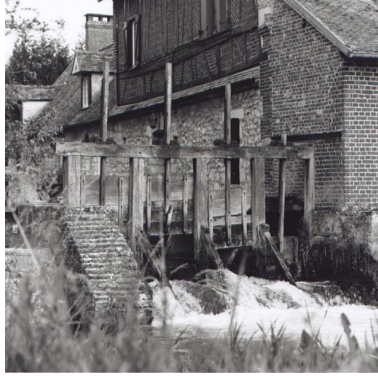
Les vannes de décharge. Phot. Thierry Lefébure IVR22_20026000690X
