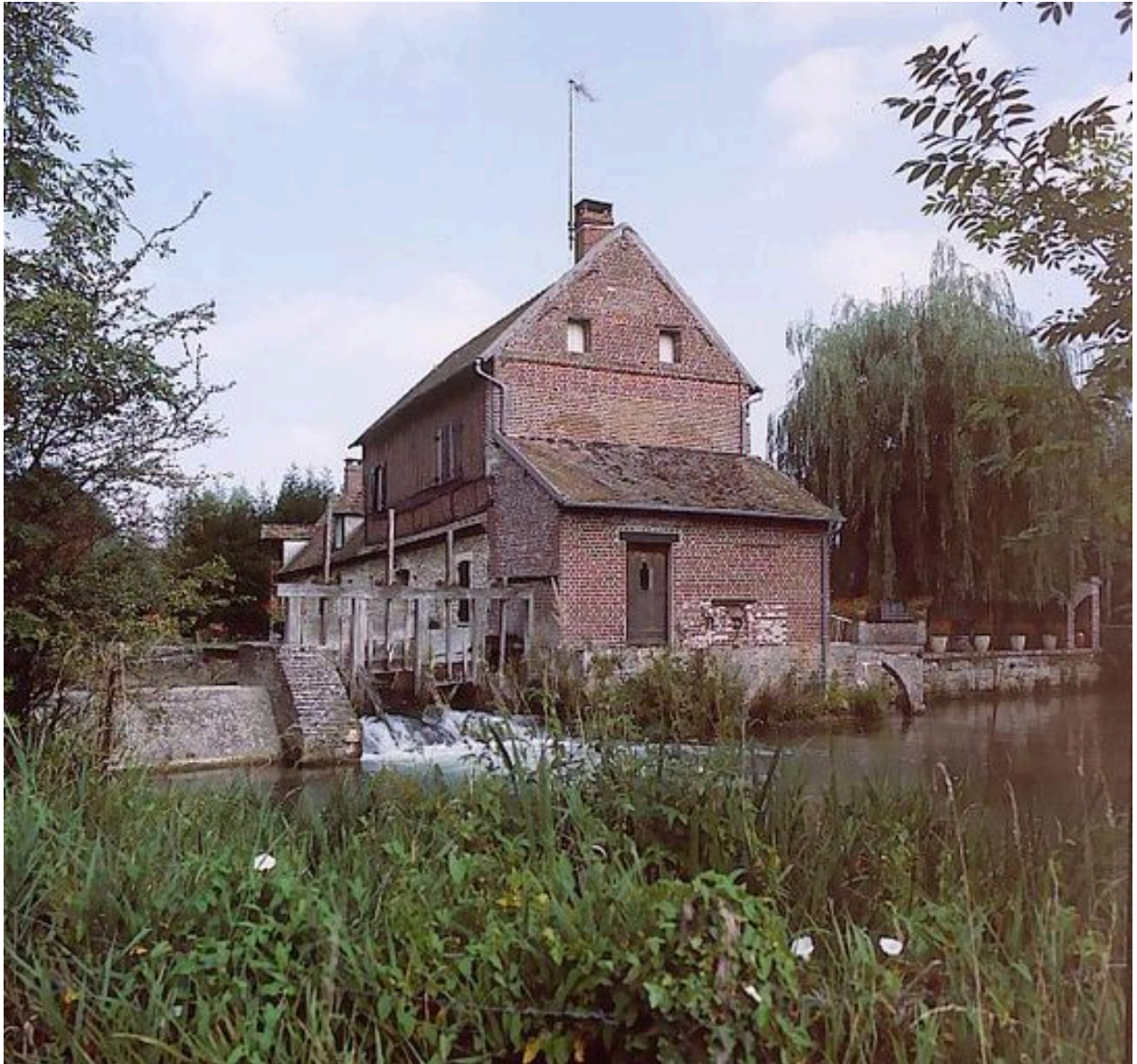
Vue d'ensemble sud-ouest du moulin.
