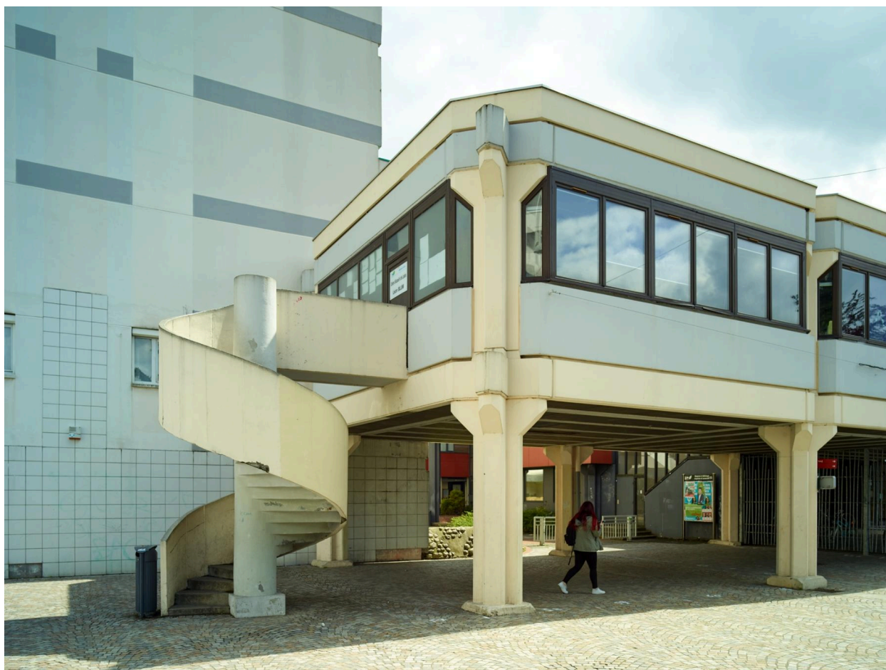
Le bâtiment du centre d'accueil et de loisirs, fermant la place Léon-Blum, jouxtant l'immeuble le plus occidental de l'îlot 7.
