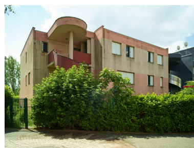
Les logements de fonction : façade sur le chemin des Bergères, au nord.
