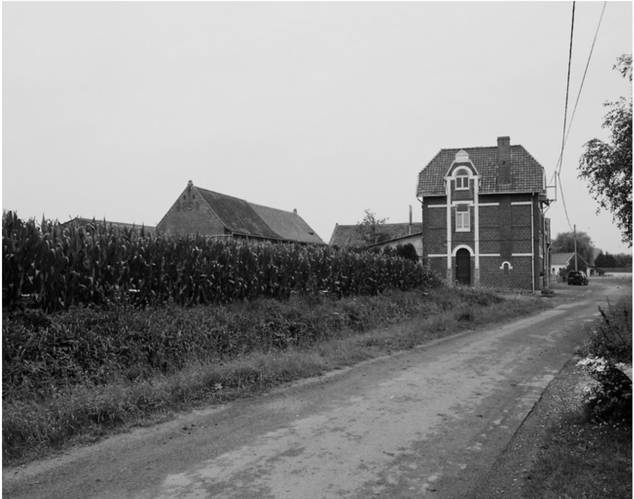
Vue générale latérale : logis reconstruit et grange.
