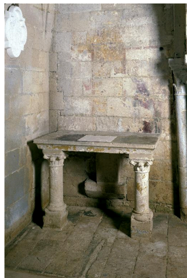
Vue de l'autel en cours de restauration (2001). Phot. Thierry Lefébure IVR22_20010202657XA
