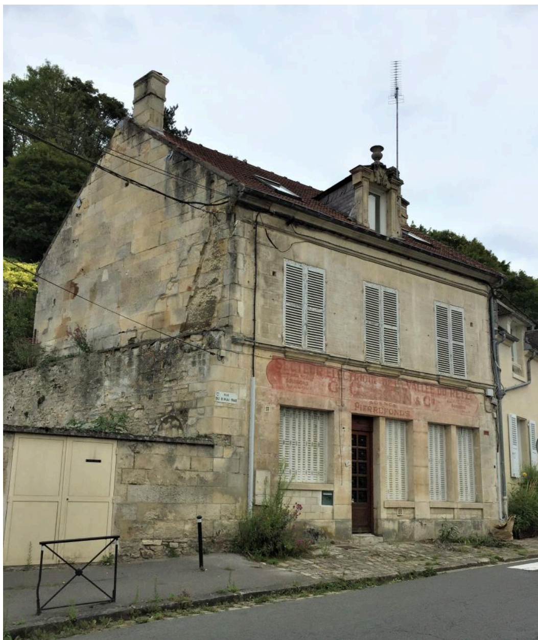
Ancienne agence commerciale, façade sud-est, vue depuis la rue.
