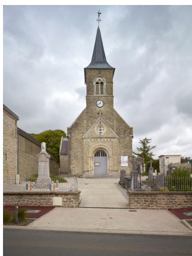
Vue générale. Phot. Pierre Thibaut IVR32_20246200168NUCA
