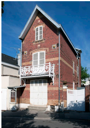
Vue générale. Phot. Pierre Thibaut IVR31_20146202231NUCA
