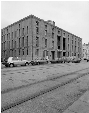
Façade sur quai de la Citadelle, après transformation en établissement d'enseignement et musée, en 1987. Phot. Jean-Michel Périn IVR31_19885901520X
