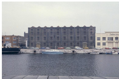
Vue générale sur le bassin du Commerce. Phot. Philippe Caudroit IVR31_19805900331ZA
