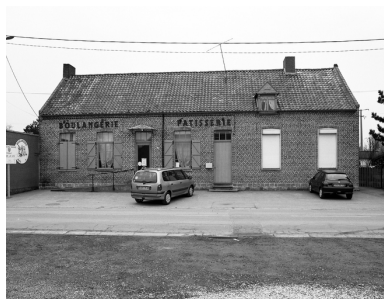
Vue générale, élévation antérieure.
