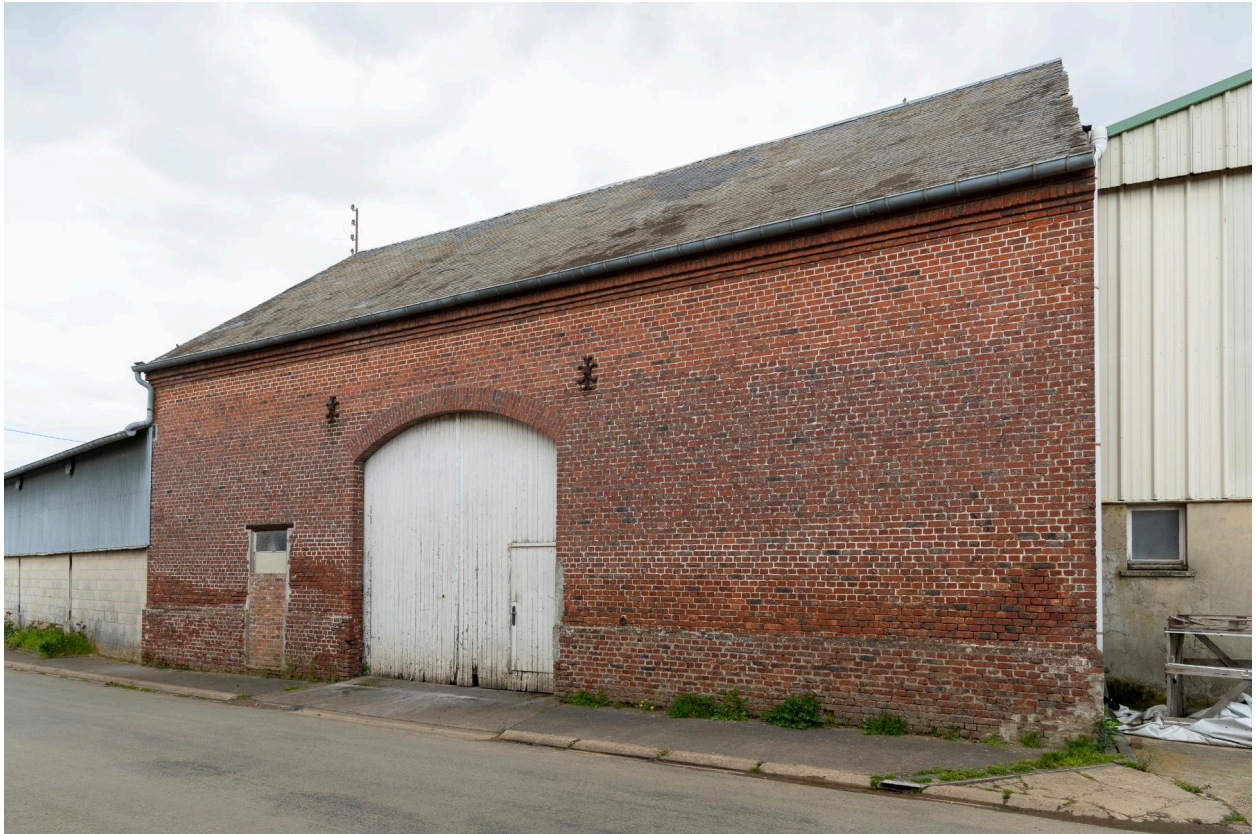
Grange reconstruite en brique, n°10 de la rue des Charrons, vue prise depuis le sud-ouest.
