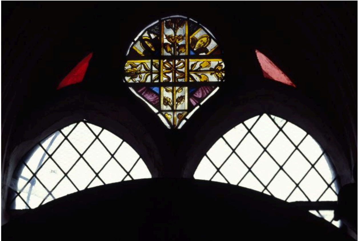
Vue de la partie supérieure de la baie 0.
