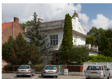
Vue générale. Phot. Hubert Bouvet IVR31_20105900376NUC4A
