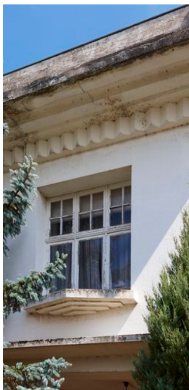
Façade, étage, détail : baie, auvent et corniche. Phot. Hubert Bouvet IVR31_20105900378NUC4A
