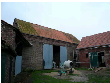
Vue de la grange. Phot. Inès Guérin IVR22_20078005549NUCA
