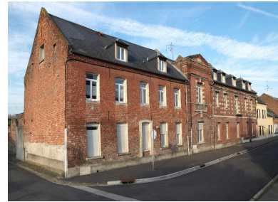
Vue générale, depuis le sud. Phot. Marie-Laure Monnehay-Vulliet IVR22_20158001055NUC2A
