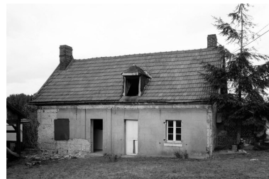
Logis. Elévation antérieure. Phot. Jean-Michel Perrin IVR22_19856000981X
