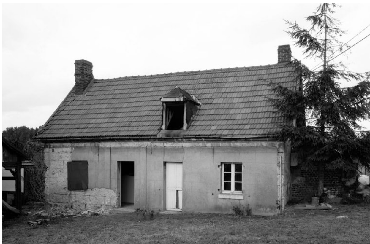
Logis. Elévation antérieure.
