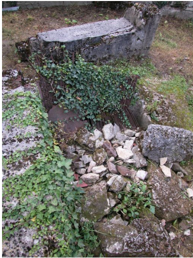
Détail de la grille du canal d'amenée comblé. Phot. Bertrand Fournier IVR22_20046003220NUCA
