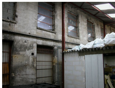
Elévation partielle de la filature Elie. Phot. Bertrand Fournier IVR22_20046003208NUCA
