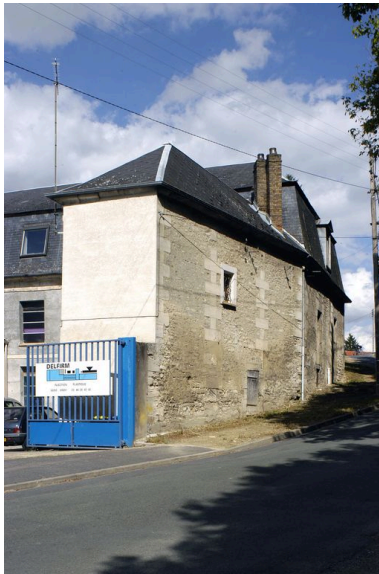
Vue de l'entrée de l'usine et de la façade sur rue de l'usine. Phot. Thierry Lefébure IVR22_20046000388NUCA
