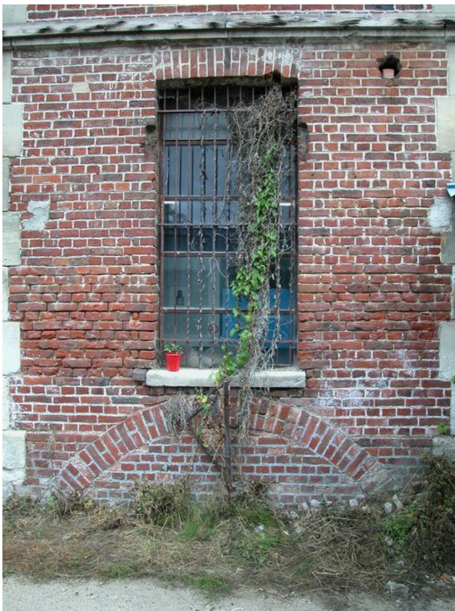
Atelier de fabrication en brique, détail d'une ouverture et de l'appareillage indiquant l'accès au sous-sol.
