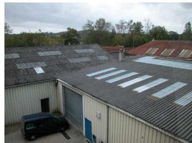
Vue des constructions en essentages de tôles nervurées implantés construits contre les anciens bâtiments, vue sur cour.
