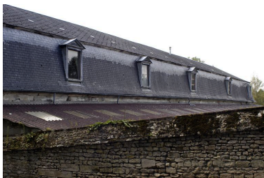
Vue de la partie supérieure de l'atelier de filature, façade postérieure. Phot. Thierry Lefébure IVR22_20046000391NUCA
