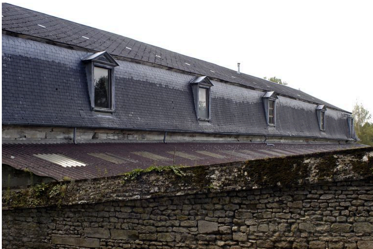
Vue de la partie supérieure de l'atelier de filature, façade postérieure.
