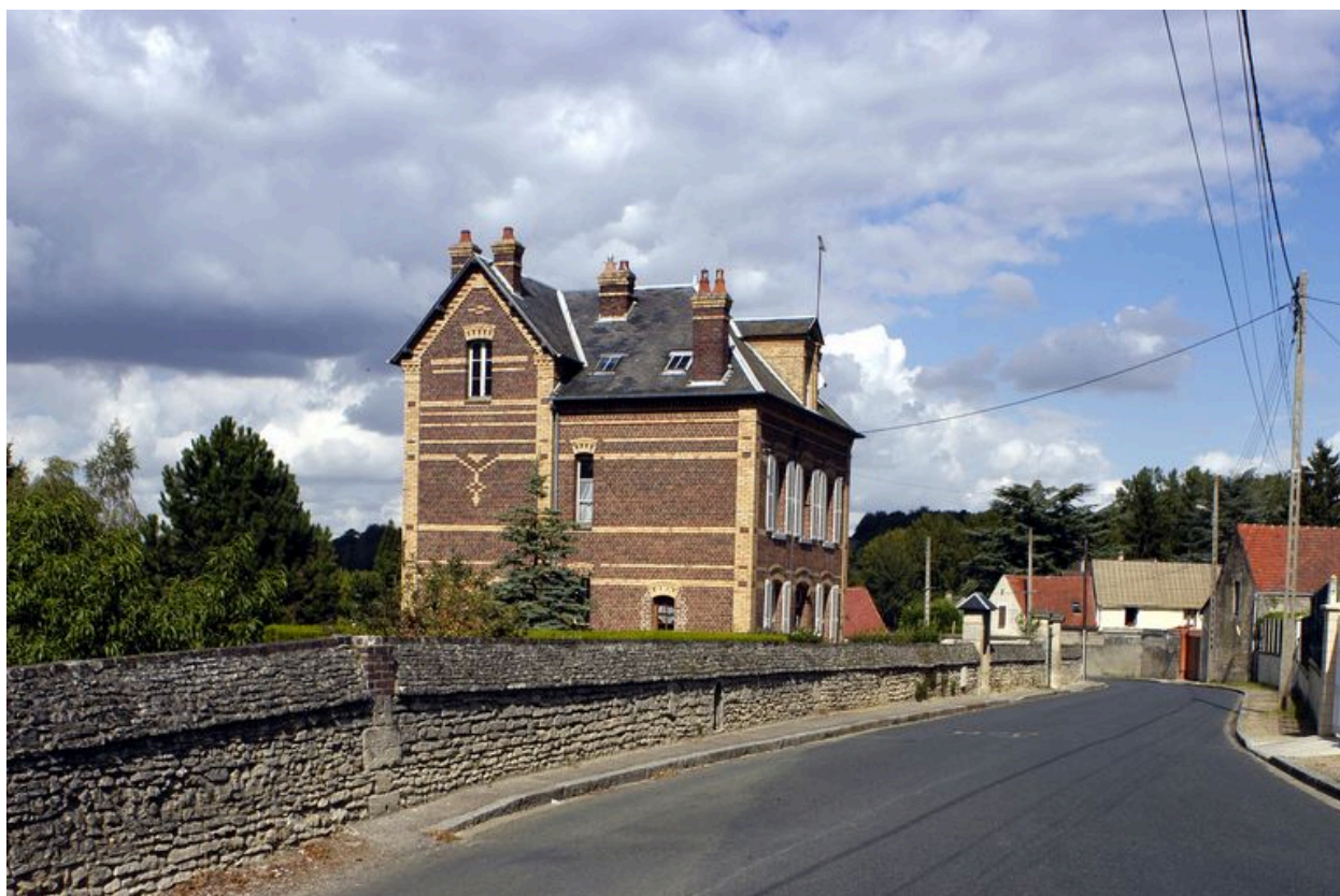
Le second logement patronal, vue d'ensemble.
