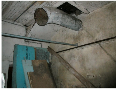
Détail de l'arrivée de la conduite forcée qui alimentait la roue hydraulique par dessus. Phot. Bertrand Fournier IVR22_20046003213NUCA
