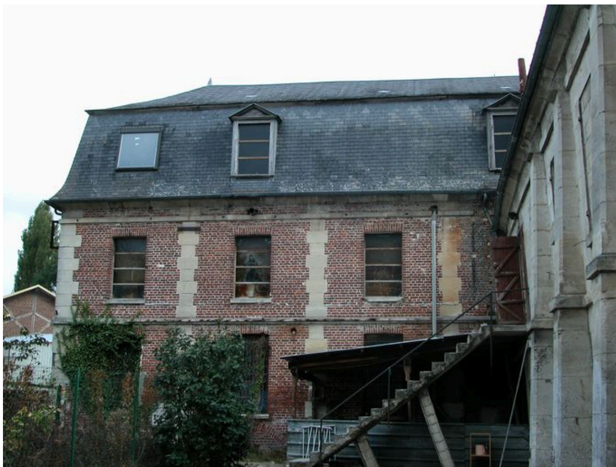
Extension en brique de la filature.
