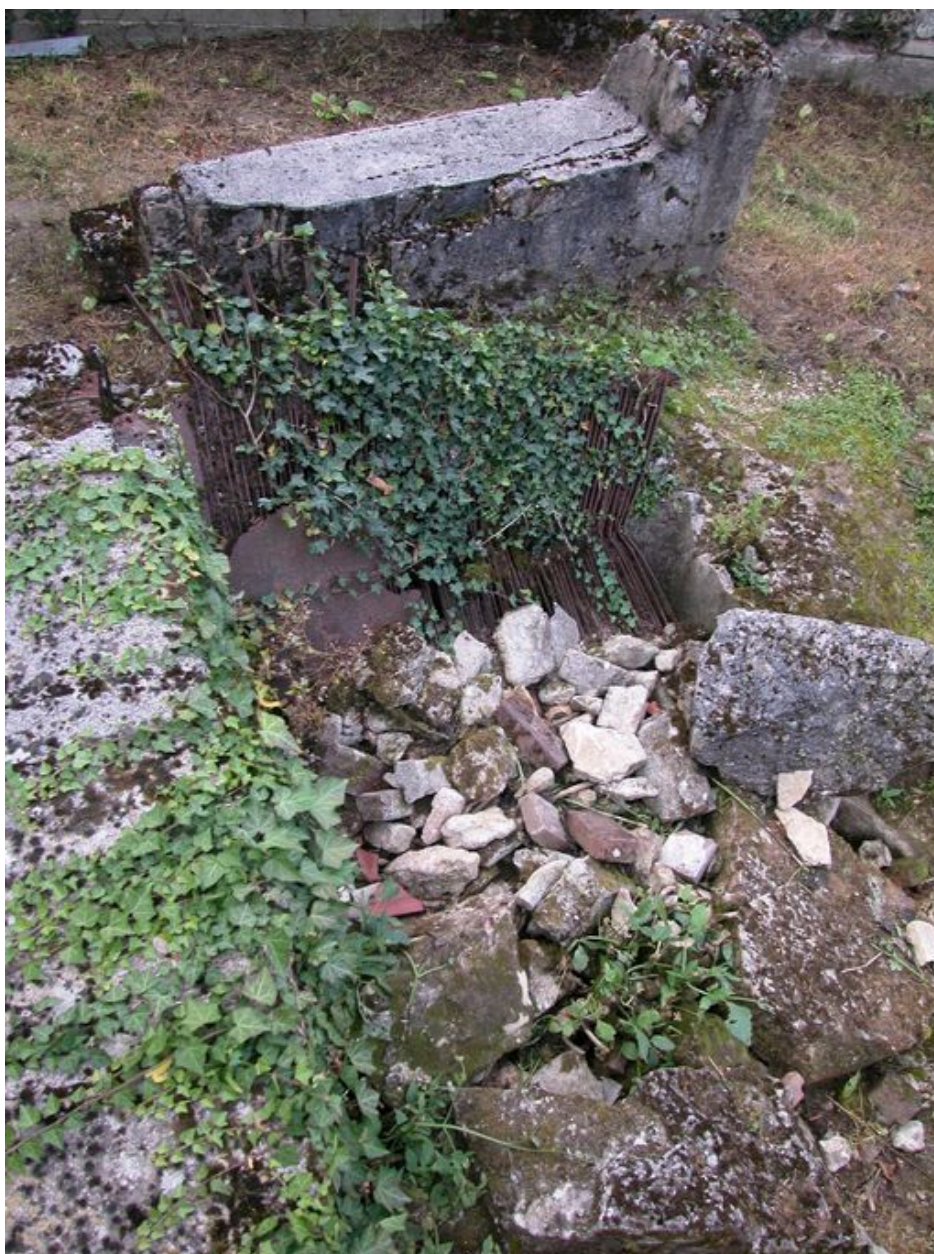
Détail de la grille du canal d'amenée comblé.
