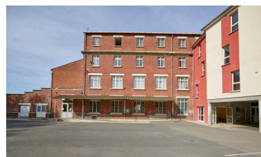
Vue de la cour et des façades arrières. Phot. Hubert Bouvet IVR32_20196200781NUCA
