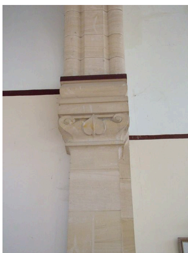
Chapiteau inachevé du chœur. Phot. Inès Guérin IVR22_20050200552NUCA
