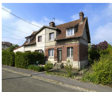
Maison de type A, vue de trois quarts (30-32 rue Victor-Hugo). Phot. Thierry Lefébure IVR32_20160200046NUC2A
