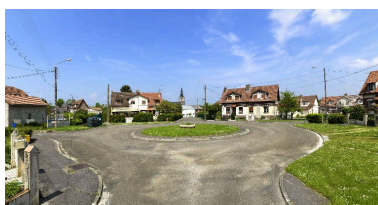
Vue générale des logements répartis autour de la place circulaire centrale. Phot. Thierry Lefébure IVR32_20160200042NUC2A
