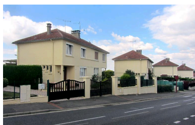
Maisons de la cité Maguin construites en 1958. Vue générale de la rue Paul-Doumer. Phot. Bertrand Fournier IVR32_20160205211NUC2A
