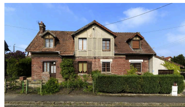
Maison de type D, vue de face (26-28 rue Victor-Hugo). Phot. Thierry Lefébure IVR32_20160200045NUC2A
