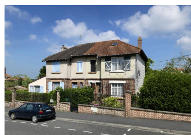
Maison d'employés à deux unités d'habitation. Type G (117-119 rue Paul-Doumer). Phot. Thierry Lefébure IVR32_20160200132NUC2A
