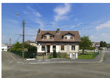
Maison de type C, façade sur rue (5-7 place Edmond-Roger). Phot. Thierry Lefébure IVR32_20160200043NUC2A
