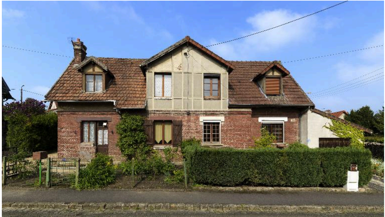
Maison de type D, vue de face (26-28 rue Victor-Hugo).
