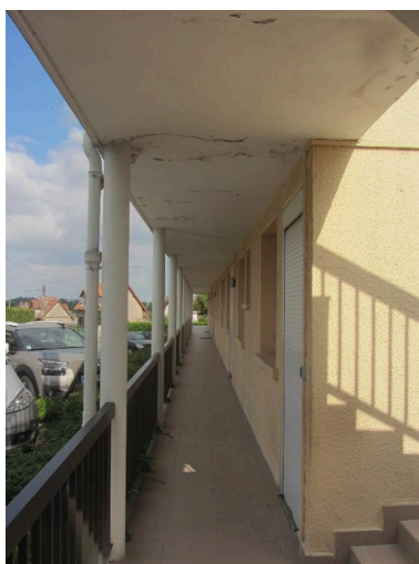
Immeuble des célibataires et des saisonniers de l'entreprise. Coursive desservant les appartements du rez-de-chaussée. Phot. Bertrand Fournier IVR32_20160205200NUCA
