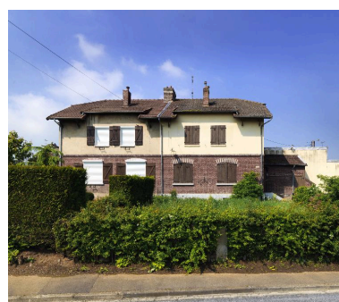
Maison de type B, à quatre unités d'habitation (8-10 rue Pasteur). Phot. Thierry Lefébure IVR32_20160200054NUC2A
