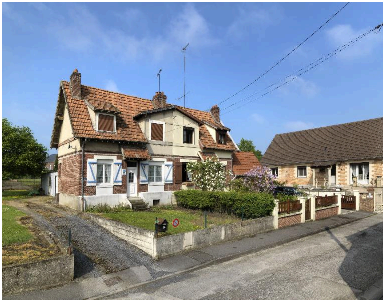
Maison de type A, vue de trois-quarts (4-4bis rue Victor-Hugo).
