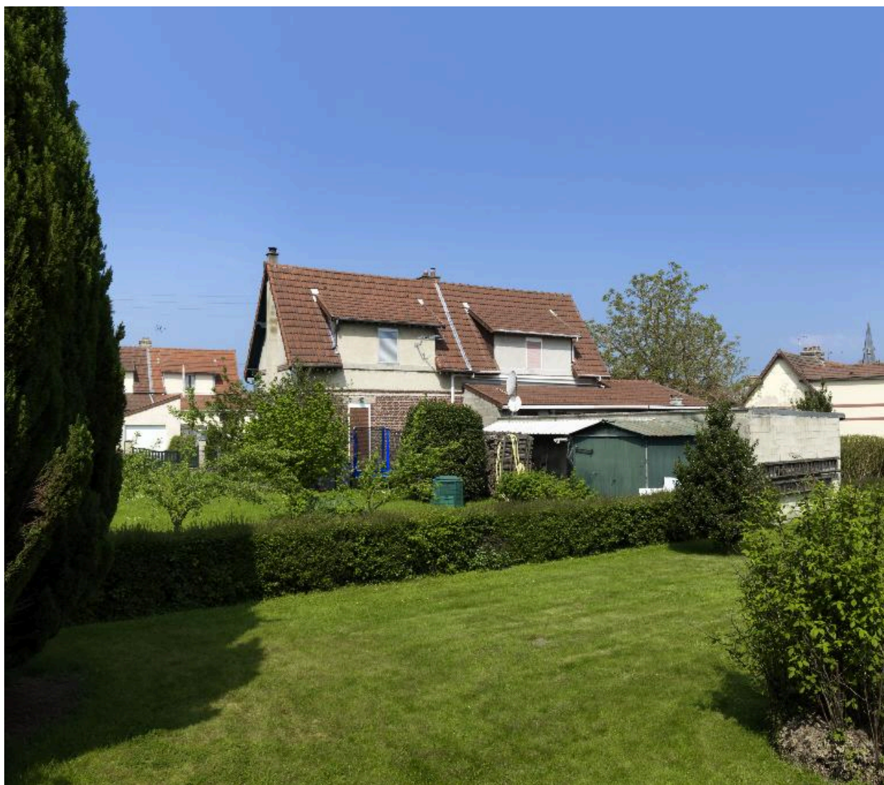
Maison de type C, vue générale de la façade arrière sur jardin (rue Pasteur).
