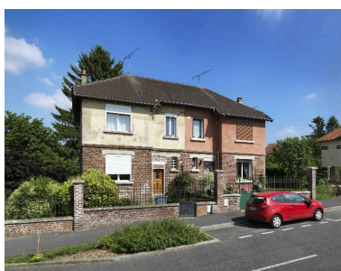
Maison d'employés à deux unités d'habitation. Type G (109-111 rue Paul-Doumer). Phot. Thierry Lefébure IVR32_20160200130NUC2A
