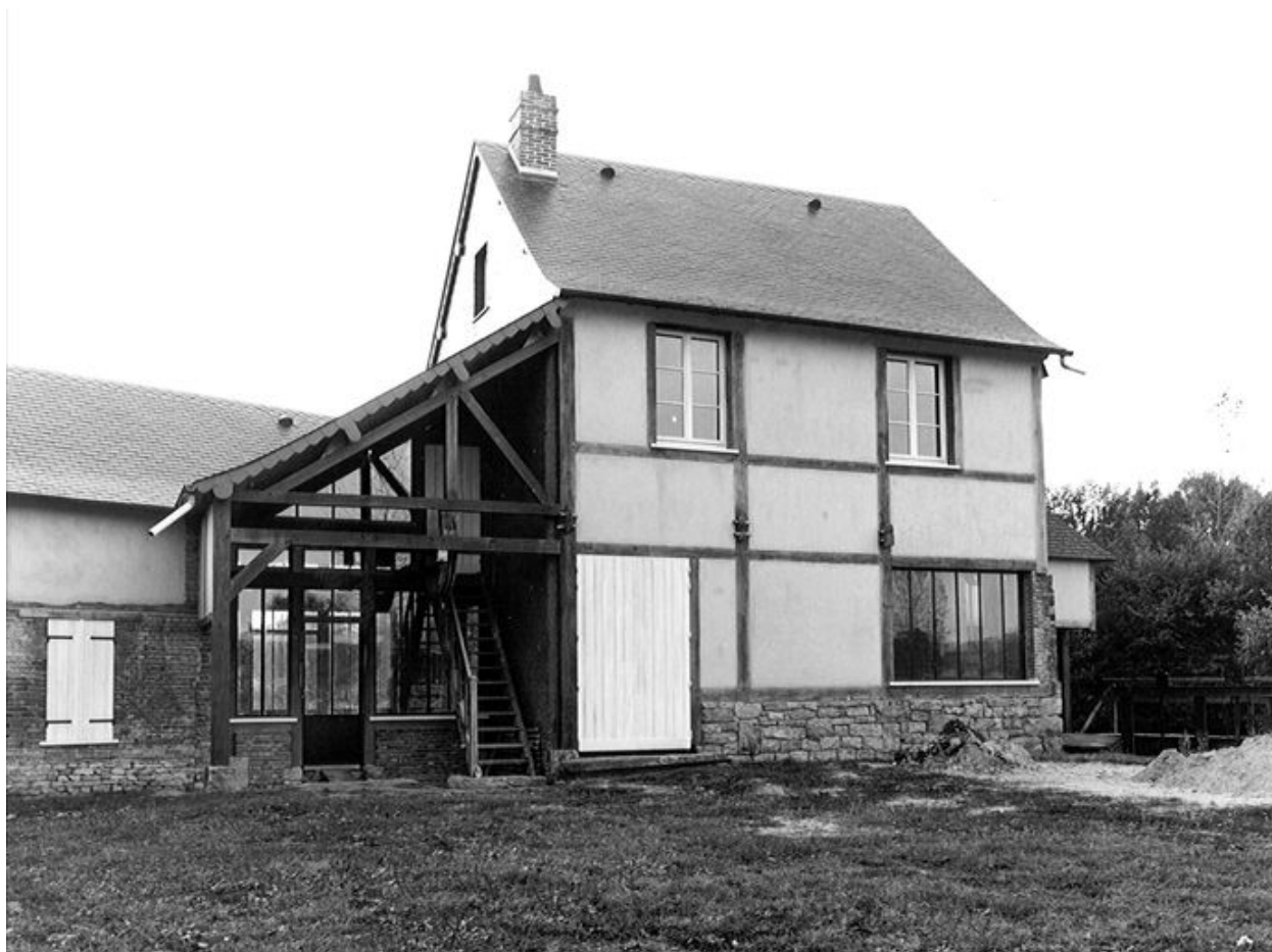
Façade ouest de l'atelier de fabrication.
