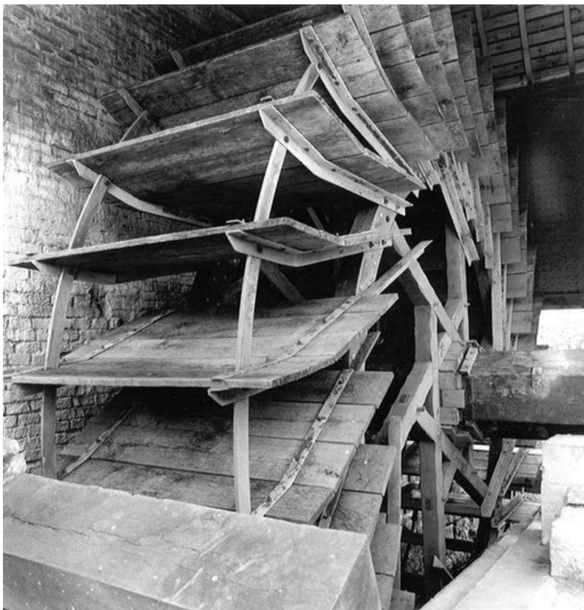
Détail de la roue hydraulique verticale.
