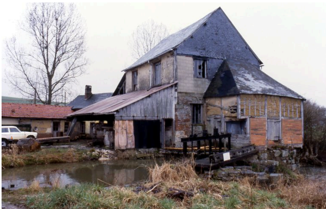
Vue d'ensemble du moulin, état en 1982.
