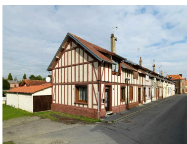
Logements, rue Docteur- Jean-Martin prolongée (rive nord), dits cité des Italiens. Phot. Thierry Lefébure IVR22_20128000860NUC2AQ
