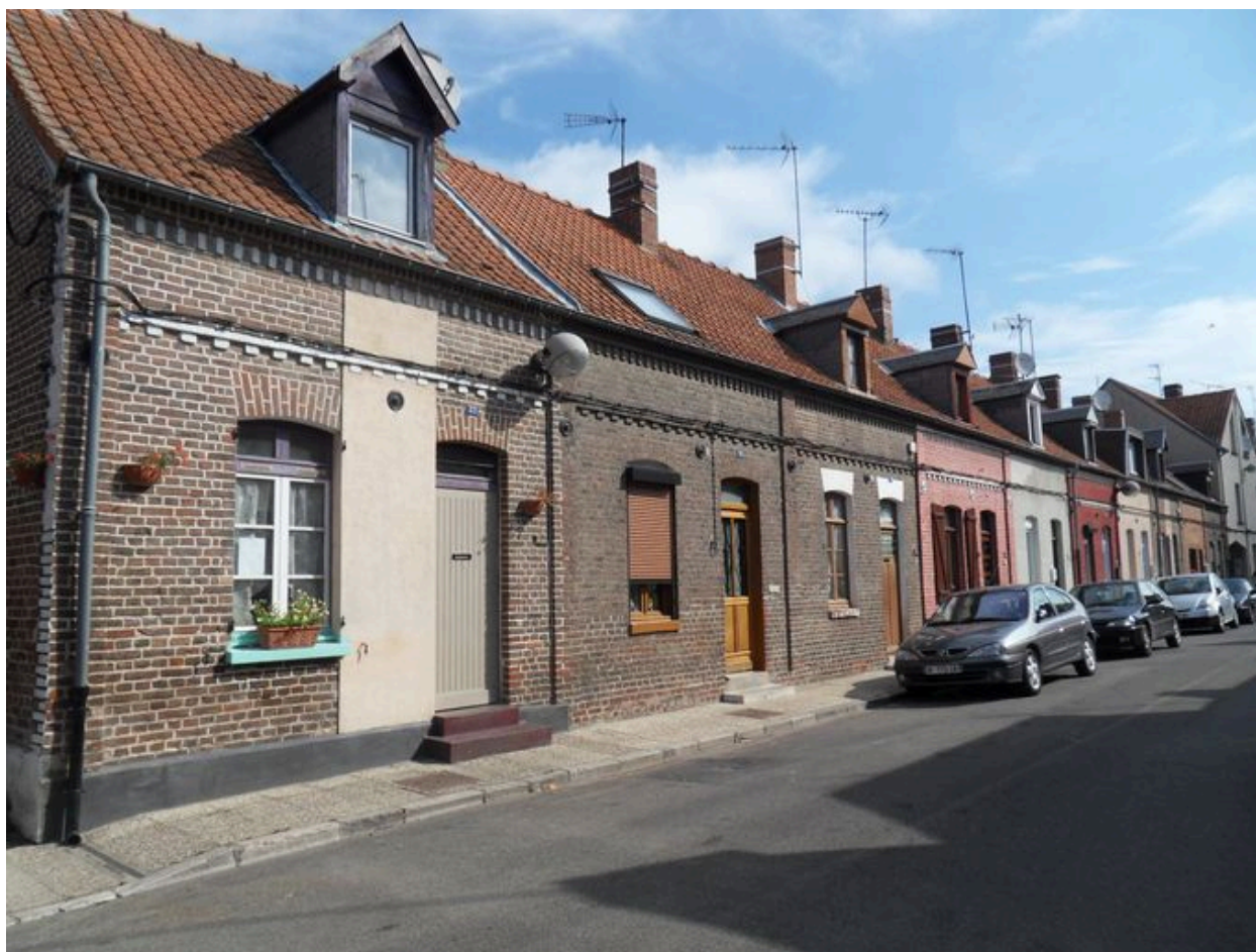
Vue des logements, rue Docteur-Jean-Martin (rive nord).
