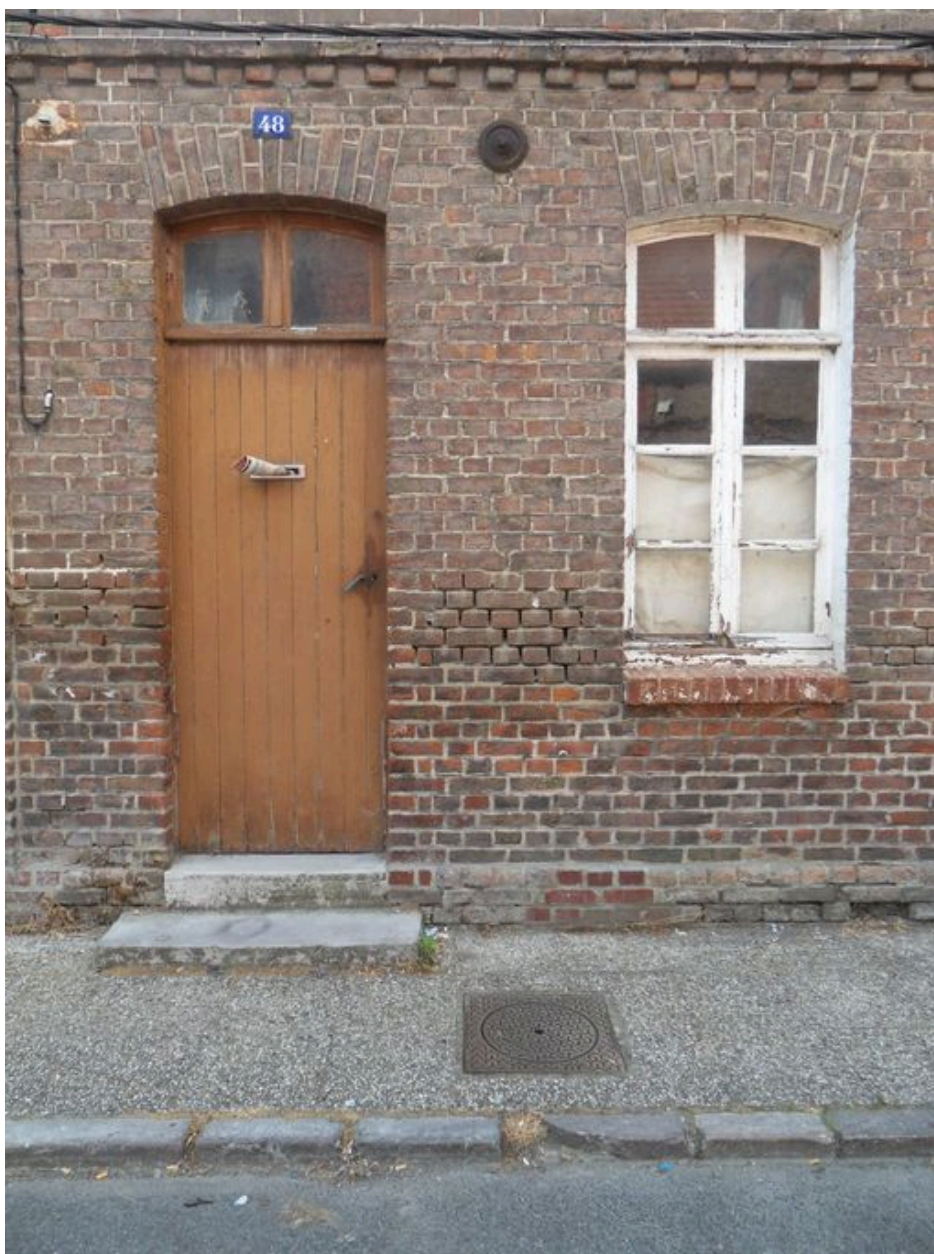
Logement, 48 rue Docteur-Jean-Martin, détail de la façade.
