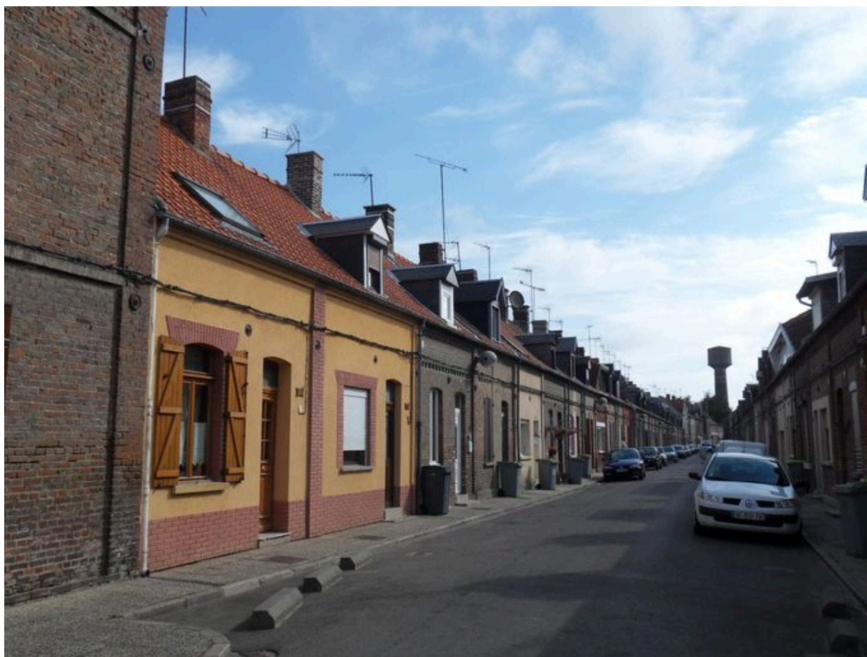
Vue des logements, rue Docteur-Jean-Martin (rive nord).
