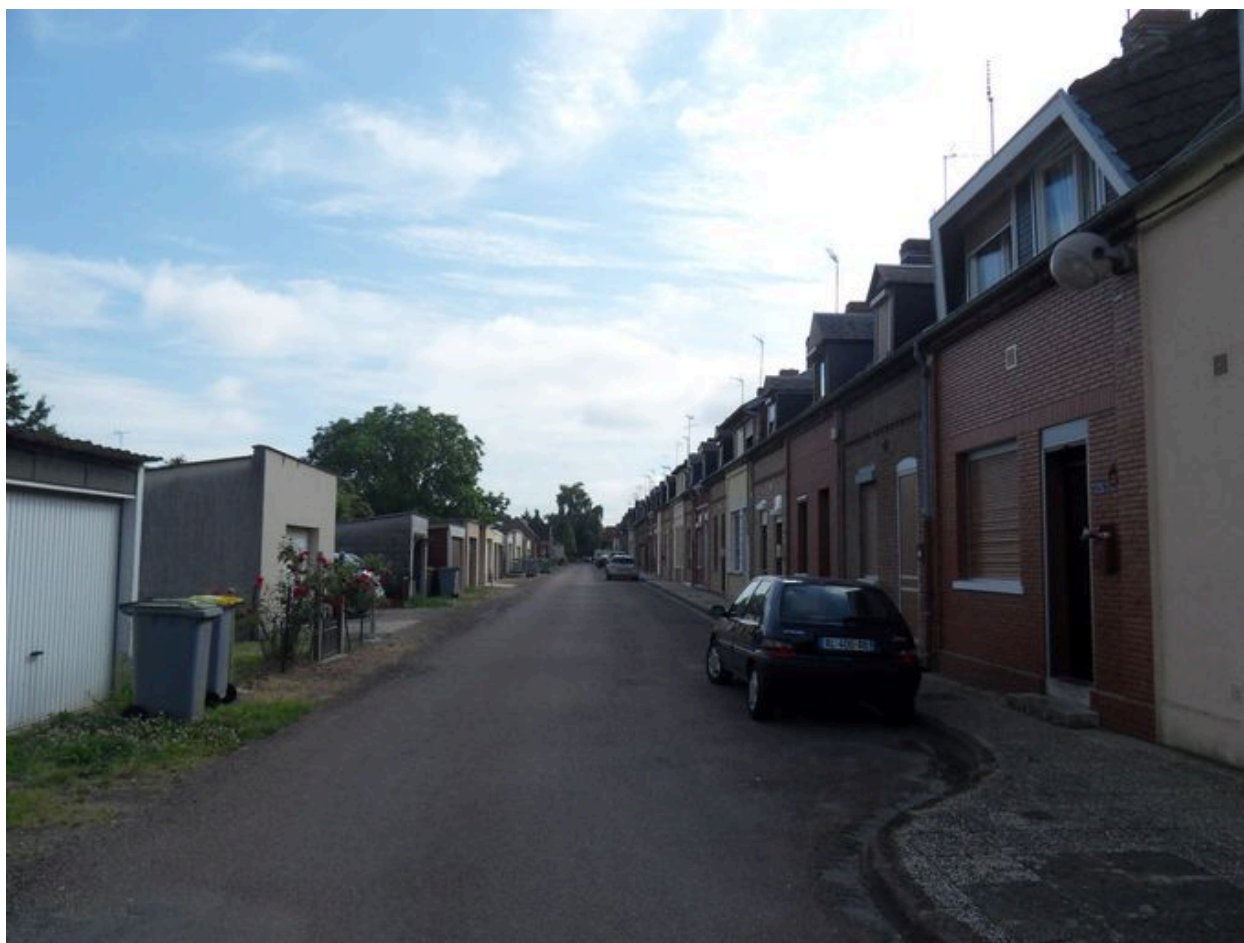
Vue générale rue Pasteur, depuis le sud-ouest.
