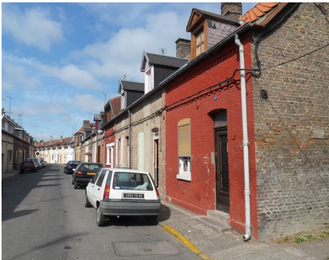
Vue des logements, rue Docteur-Jean-Martin (rive sud).
