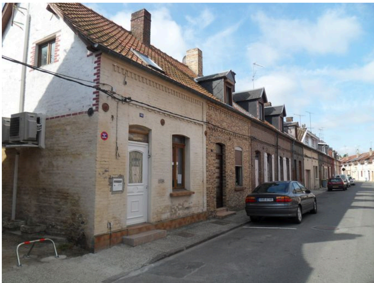
Vue des logements, rue Docteur-Jean-Martin (rive sud).
