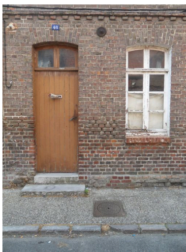
Logement, 48 rue Docteur- Jean-Martin, détail de la façade. Phot. Isabelle Barbedor IVR22_20108001482NUCA
