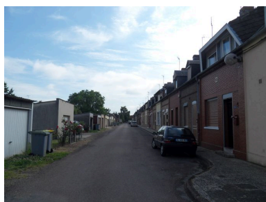
Vue générale rue Pasteur, depuis le sud-ouest. Phot. Isabelle Barbedor IVR22_20108001474NUCA
