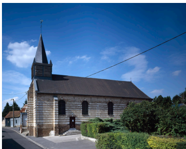
Saint-Vaast-en-Chaussée, église paroissiale Saint-Vaast. Phot. Irwin Leullier IVR22_19988000842VA
