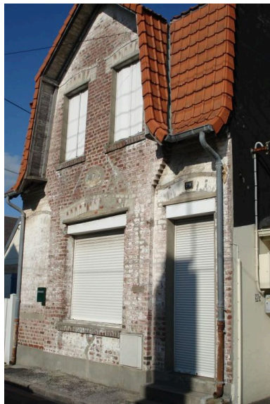
Vue générale. Phot. Julie Faure IVR31_20066200208NUCA
