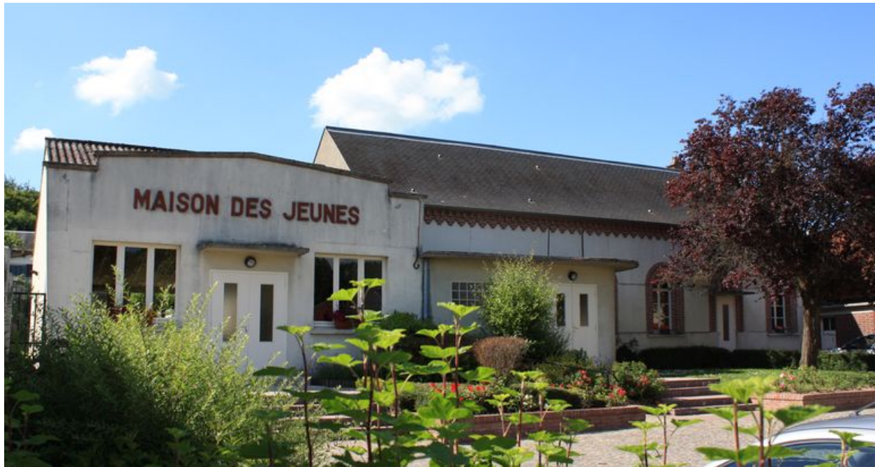
Façade sur rue de l'ancienne école de filles et de la salle des fêtes.
