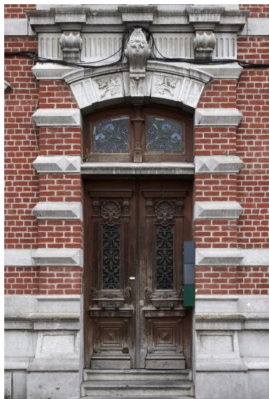
Détail : porte d'entrée, rue Descartes. Phot. Delphine Volto Jourdan IVR32_20265900091NUCA
