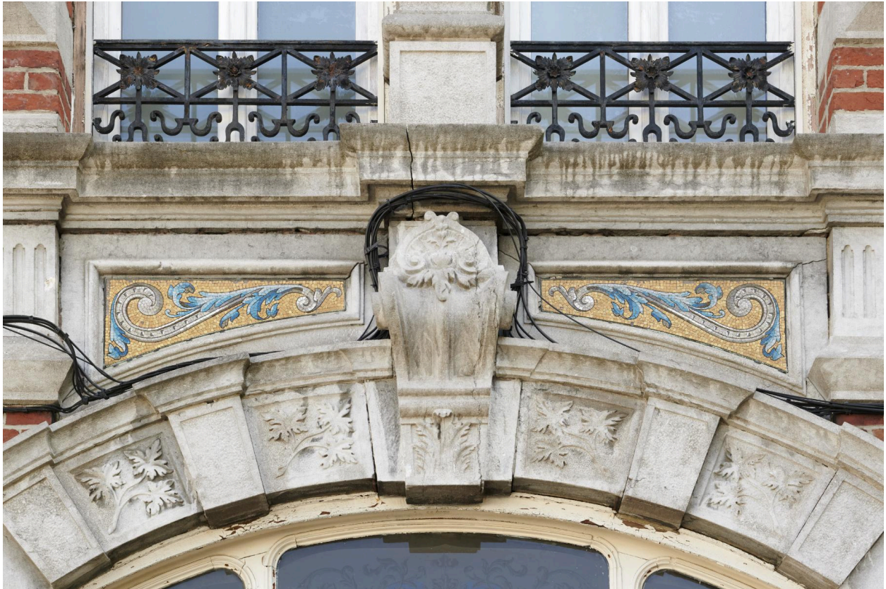
Détail : clef de voûte de la fenêtre basse de l'angle.
