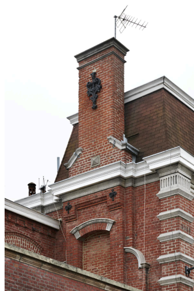
Détail du pignon de la façade rue Descartes. Phot. Delphine Volto Jourdan IVR32_20265900092NUCA
