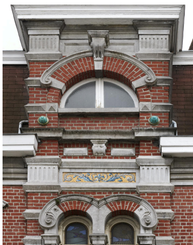
Détail : pignon droit de la façade rue Descartes. Phot. Delphine Volto Jourdan IVR32_20265900089NUCA
