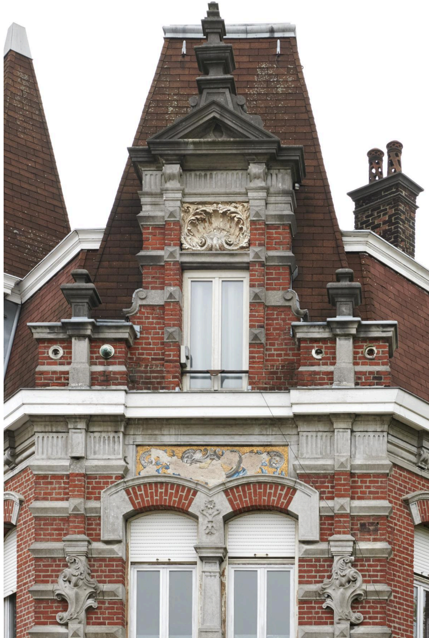
Détail : pignon droit de la façade d'angle.
