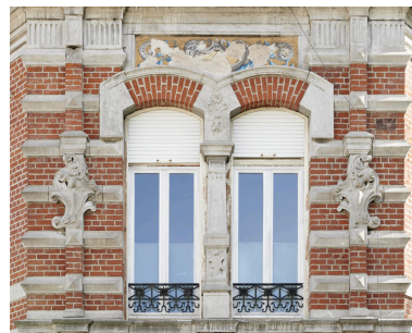
Détail : ornements autour des fenêtres du 1er étage de l'angle, dont une mosaïque partielle. Phot. Delphine Volto Jourdan IVR32_20265900048NUCA
