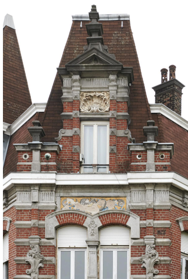
Détail : pignon droit de la façade d'angle. Phot. Delphine Volto Jourdan IVR32_20265900087NUCA
