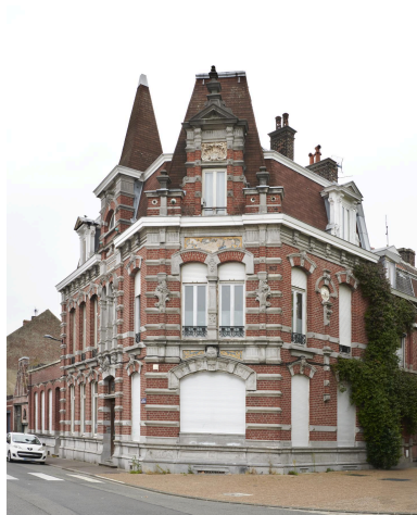
Vue générale de la façade d'angle rue Descartes et place Edouard-Roussel.
