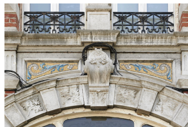
Détail : clef de voûte de la fenêtre basse de l'angle. Phot. Delphine Volto Jourdan IVR32_20265900045NUCA
