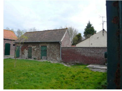
Vue des étables à l'est de la cour. Phot. Inès Guérin IVR22_20078005711NUCA
