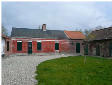
Vue du logis au fond de la cour. Phot. Inès Guérin IVR22_20078005710NUCA
