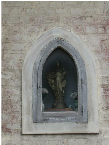
Détail de la niche percée en façade d'un des logements (AH 793). Phot. Elisabeth Justome IVR22_20058003214NUCA
