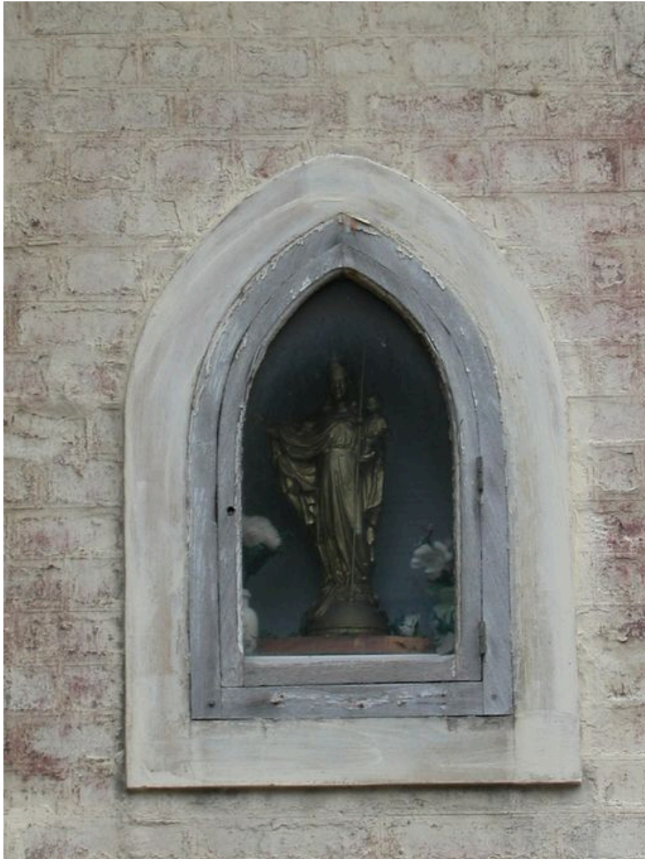
Détail de la niche percée en façade d'un des logements (AH 793).
