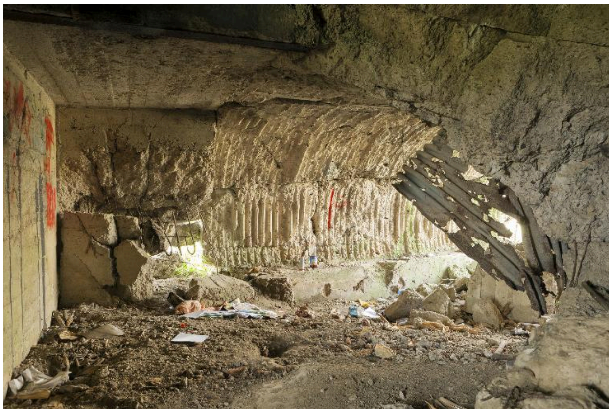
Edifice b. Vue intérieure depuis l'entrée
