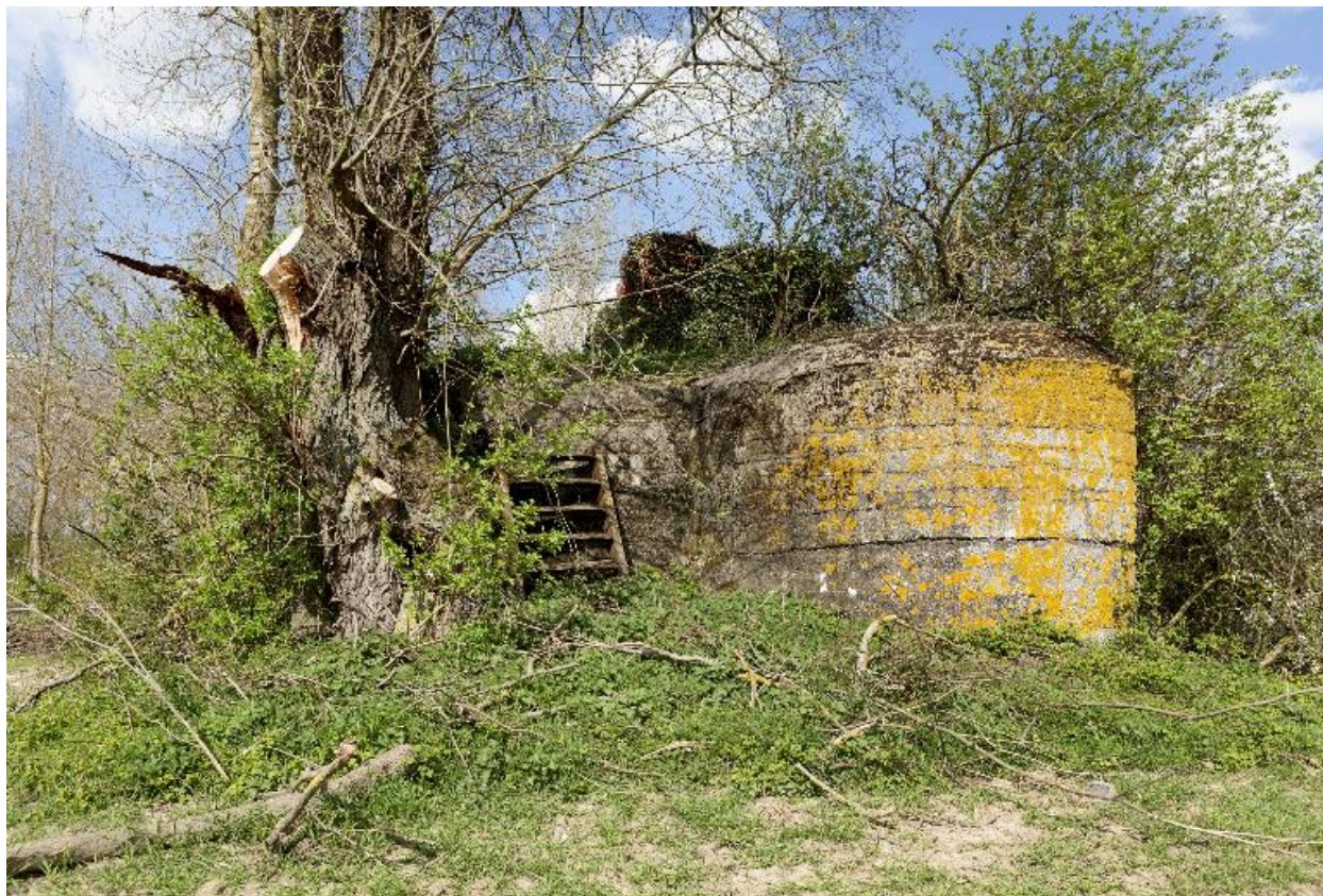
Edifice b vers le nord. L'escalier métallique et la structure sur le couverture ne sont pas d'origine.
