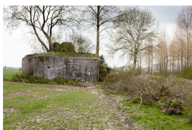
Edifice b : Elévation nord-est
