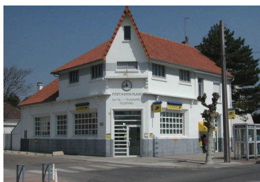
Vue d'ensemble depuis l'avenue. Phot. Elisabeth Justome IVR22_20038005423NUCA
