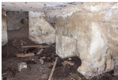
Casemate B : Vue intérieure, vers le sud Phot. Pierre Thibaut IVR32_20165900011NUCA
