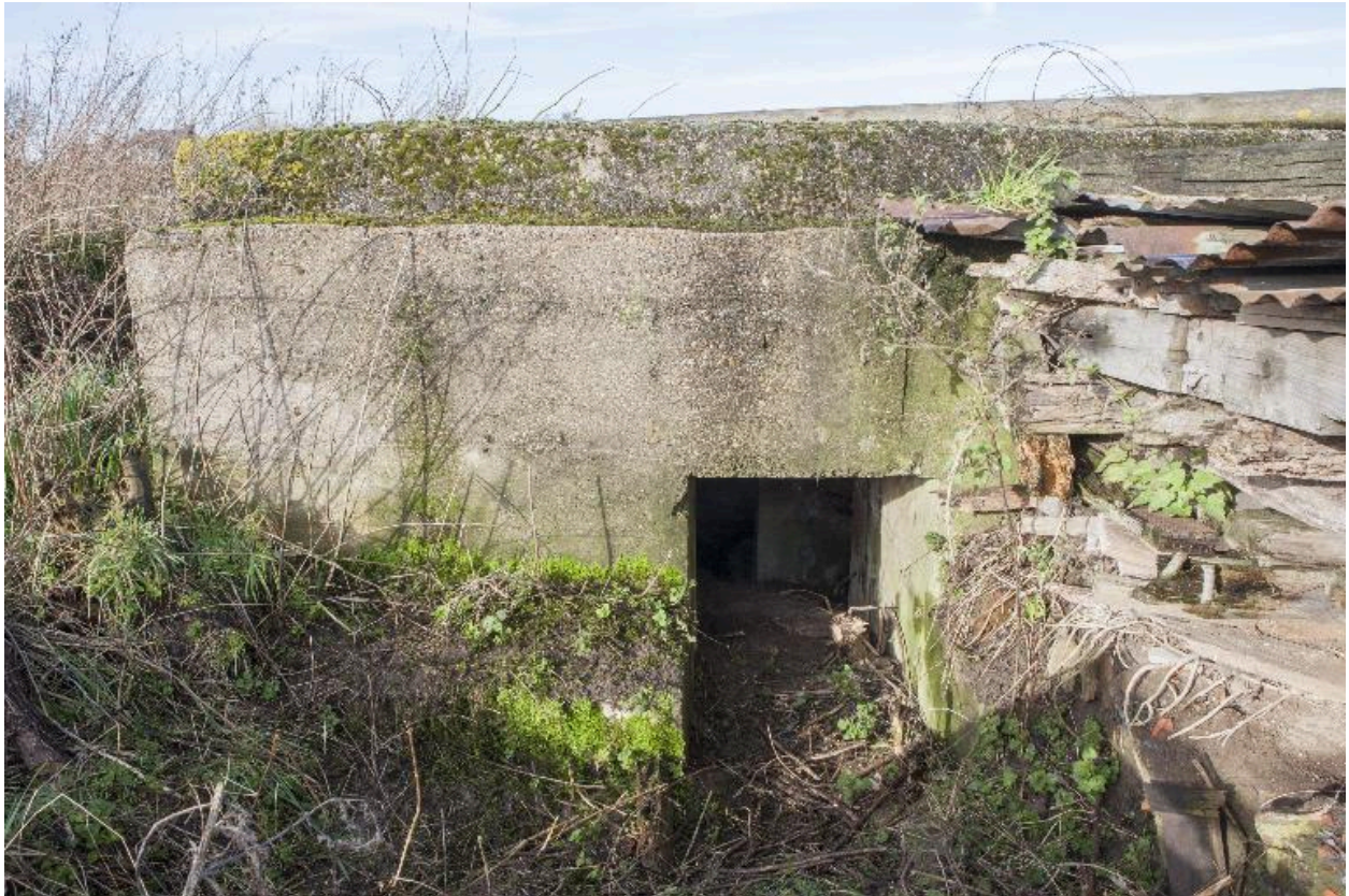
Casemate B : Elévation est, entrée sud.
