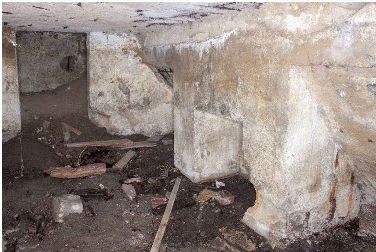
Casemate B : Vue intérieure, vers le sud
