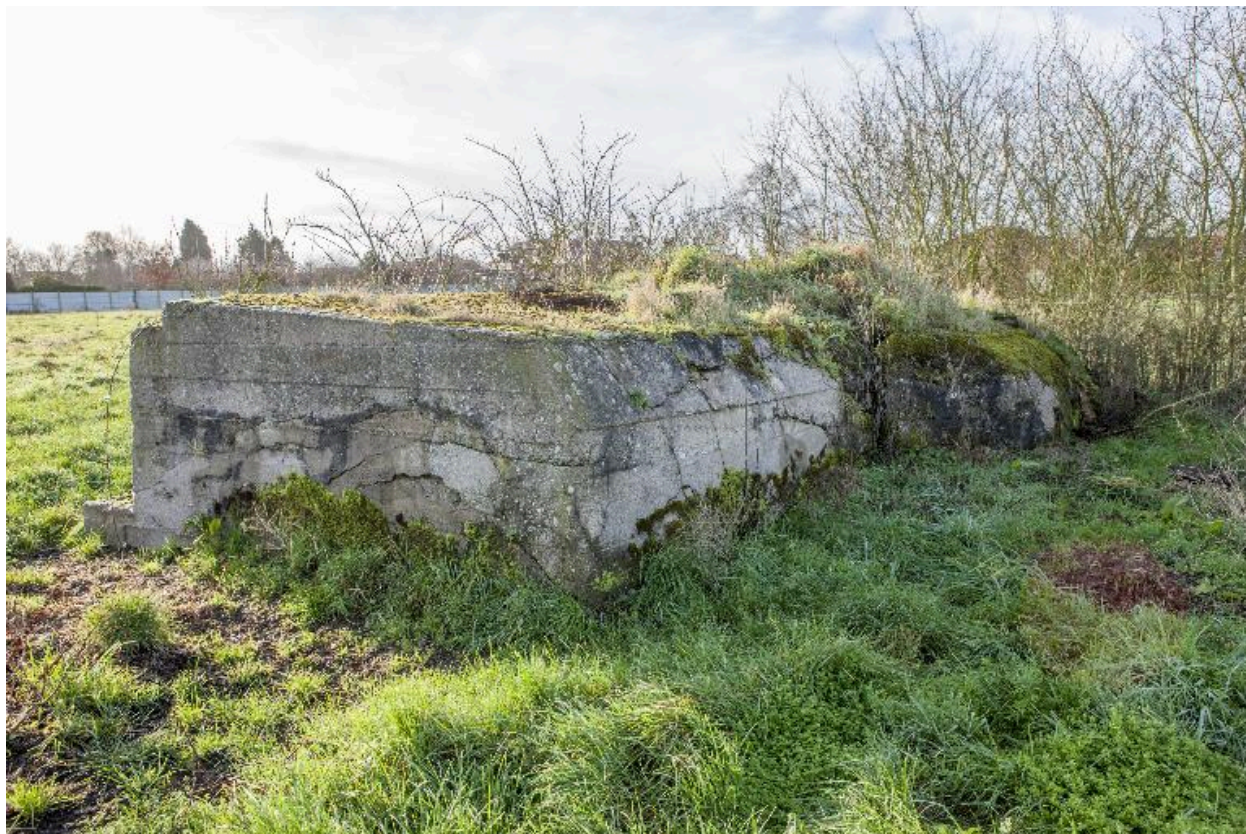
Casemate A : Vue générale vers le sud
