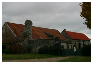
Vue générale des bâtiments agricoles. Phot. Inès Guérin IVR22_20030202010NUCA
