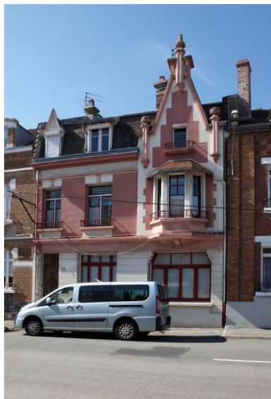
Vue générale. Phot. Pierre Thibaut IVR31_20086200193NUCA
